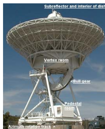
Figura 2.11: Partes de un radiotelescopio.
