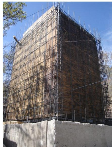
Fig. 42 Acero en el tanque mezclador ▶
