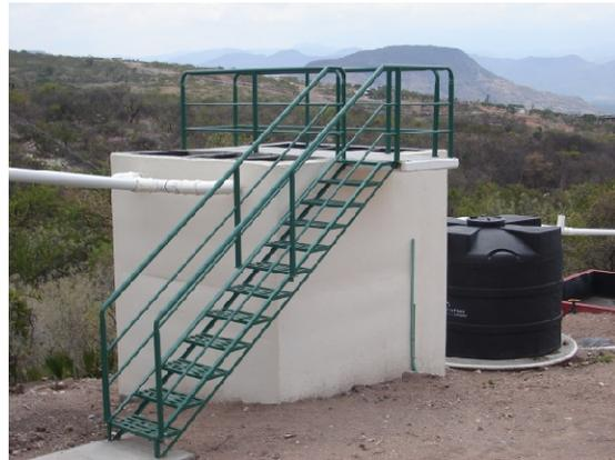
▲ Fig. 58 Tanque sedimentador
