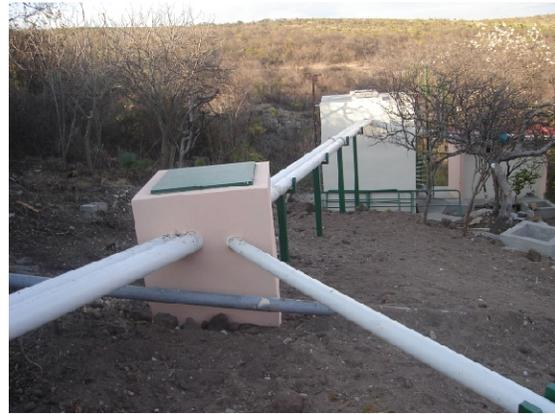
▲ Fig. 52 Registro de aguas negras y tubería de pvc hidráulico de 6 y 4"
