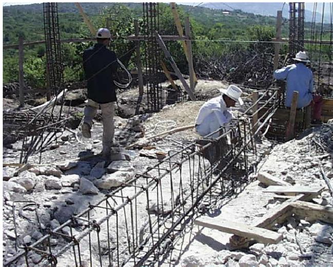
Fig.22 Contratraves para nivelación de terreno
