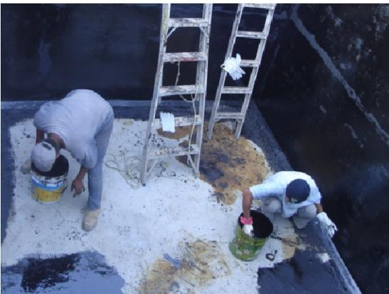
▲ Fig. 47 Impermeabilización al interior de los tanques
