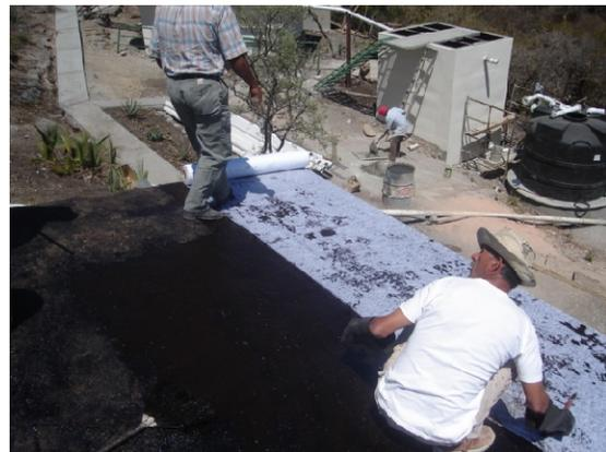
▲ Fig. 48 Impermeabilización de losas de azotea
