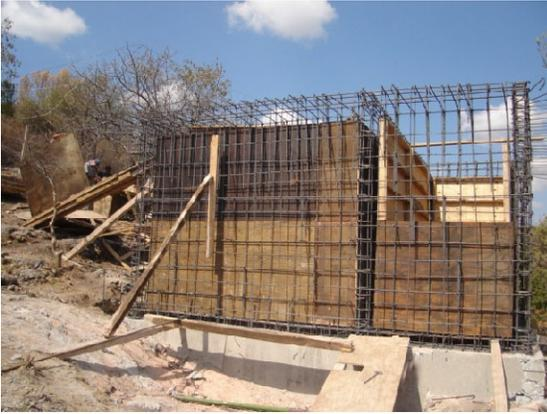
▲ Fig.43 Acero y cimbra del tanque de aireación
