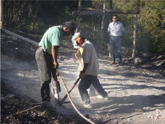
▲ Fig. 37 Desbaste de roca con martillo neumático, tanque mezclador
