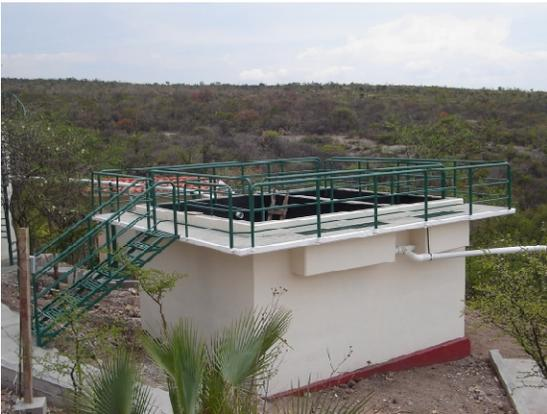
▲ Fig. 57 Tanque de aireación
