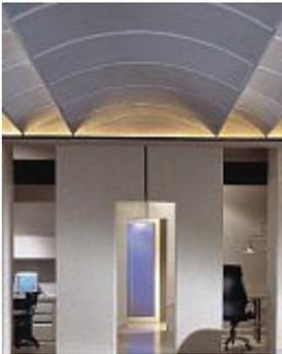
Para que un plafón sea adecuado para un centro de cuidado éste debe ayudar a mantener un ambiente acústico. Un buen plafón provee una buena absorción del sonido y la reducción del ruido. Existen productos en el mercado hechos de fibras minerales que no absorben la humedad evitando el crecimiento de hongos o bacterias, además de ser retardante del fuego. (Fig. 41)
