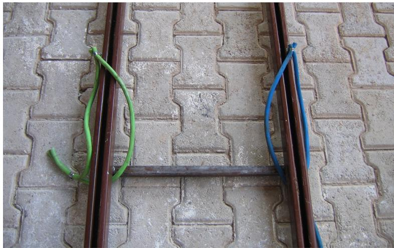
**Fig. 3.15** Bandas elásticas colocadas en los rieles
