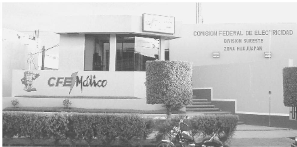
Fig. 3.8 Edificio de la Agencia Huajuapán en la Zona de Distribución Huajuapán
