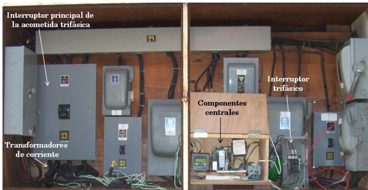
Figura 5.15. Aspecto de la instalación del sistema de pruebas de campo.
