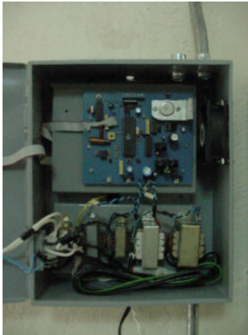
Figura 4.10 Interior del gabinete
