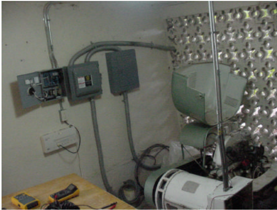
4.12 Vista general de la planta de energía eléctrica y el sistema de control instalado
