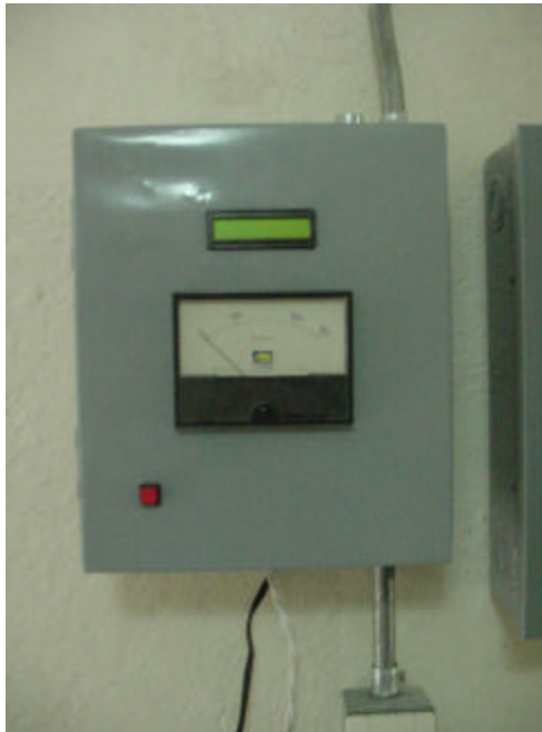
Figura 4.8 Vista frontal del gabinete
