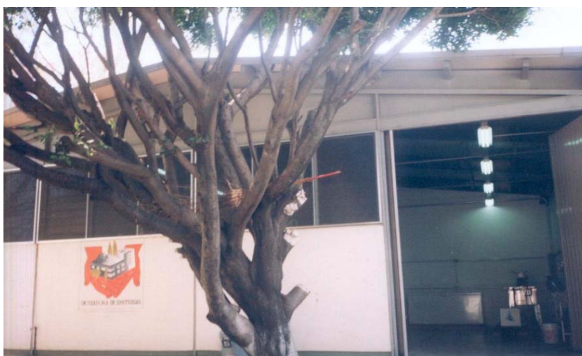
Figura A.2 Instalaciones físicas de la Incubadora
