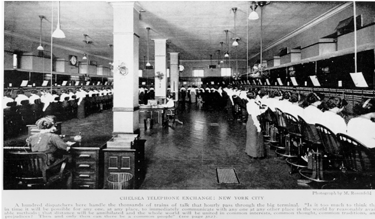
Figura 3. Central telefónica operada manualmente
