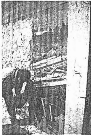
Figura 4.9. y 4.10. Instalación del poliducto para el servicio eléctrico y aplanado en muro hasta alcanzar 7cm de espesor.
