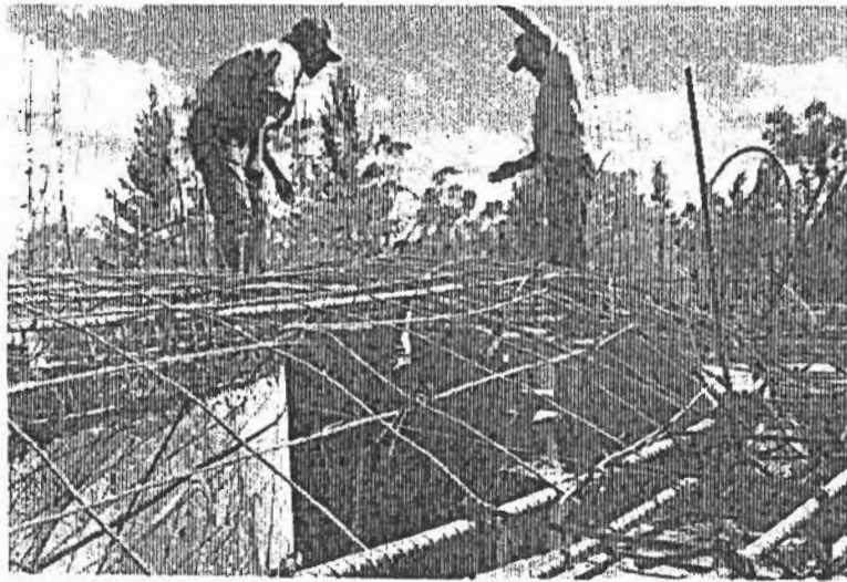
Figura 4.7. Secuencia del armado de la estructura, y su recubrimiento .
