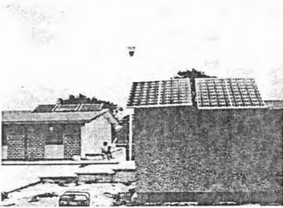
Figura 1.6. Albergue rural electrificado.
