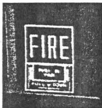
Fig. 2.16 Estación manual de alarma.
