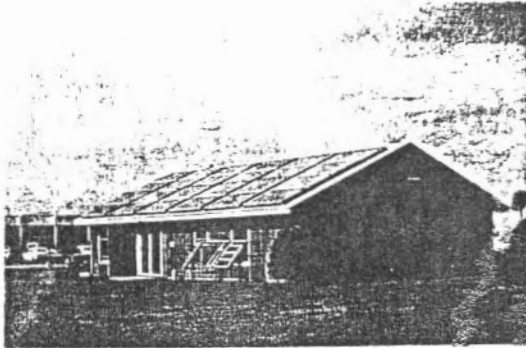
Fig. 7. Electrificación total mediante paneles fotovoltaicos.
