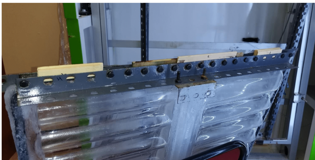
Figura 12. Montaje del tanque de microalgas sobre su base metálica, fijándolo con tornillos y tuercas de 11 mm.
