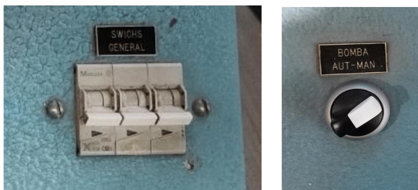
Figura 4. Switch general y perilla de encendido de la bomba de aire.
