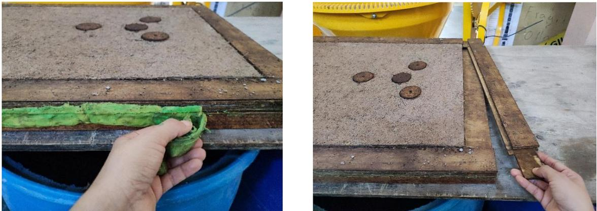
*Nota.* En la figura se observa parte del proceso del desmolde del panel. Fuente: Propia (2024).
