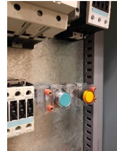
Figura 58. Módulos montados en el riel.
