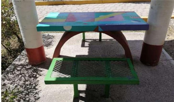
*Nota.* Mesa fabricada a base de concreto con 2 bancos de metal. Fuente: Elaboración propia (2022).
