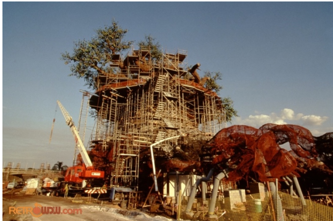
Figura 37 Montaje de ramas terciarias y follaje Tree of life
