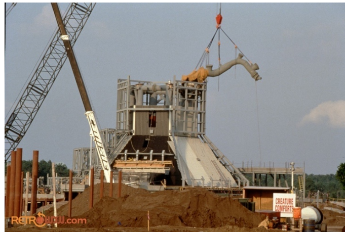
Figura 35 Montaje de estructura de ramas principales Tree of life
