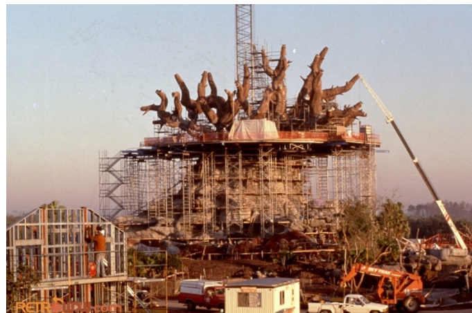
Figura 36 Montaje final de ramas secundarias Tree of life
