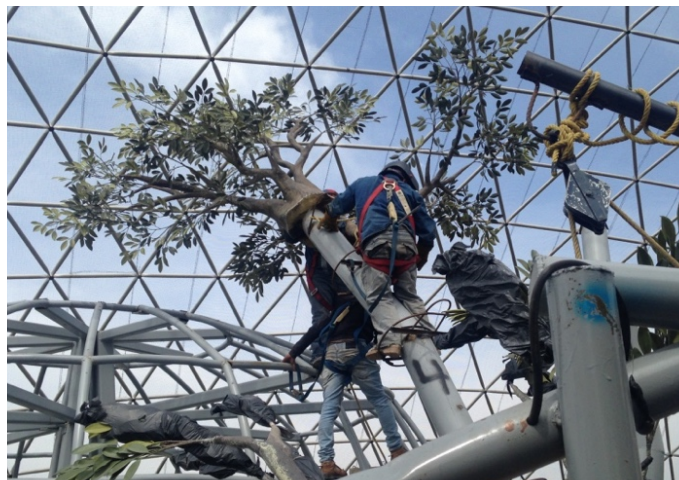
Figura 93 Instalación de rama en sitio
