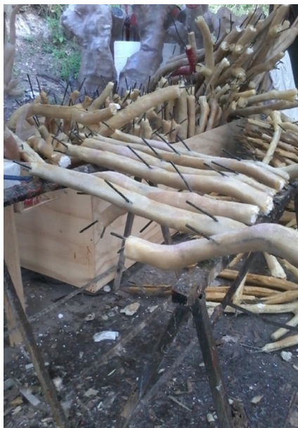
Figura 89 Sellado y refuerzo de uniones en componentes
