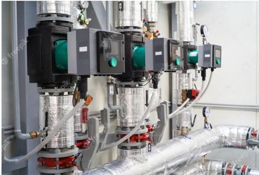
*Nota.* Sistema de control automatizado para la circulación del agua en una caldera.
