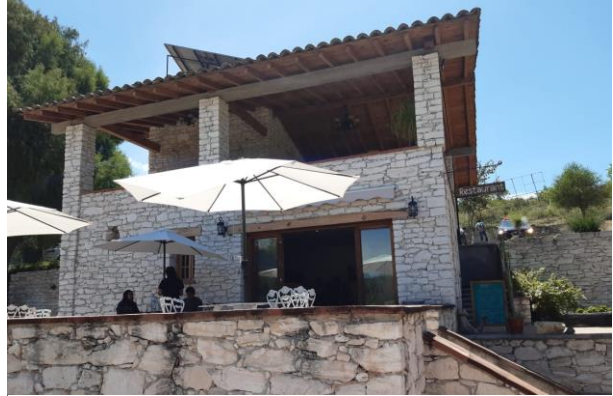
Foto 19: Vista del restaurante y en la parte de arriba la oficina. Fuente propia
