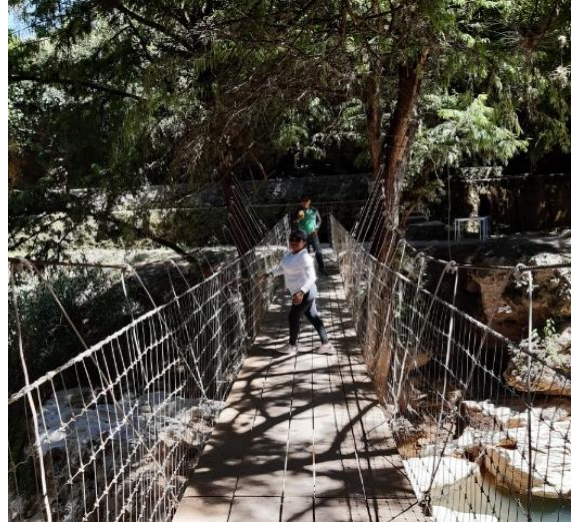
Foto 21: Puente colgante. Fuente propia.
