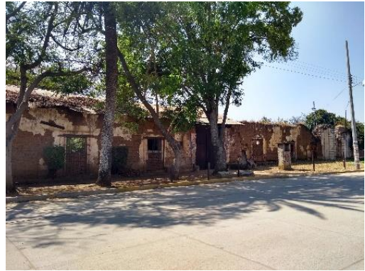
Foto 2: Fachada principal de la Ex Hacienda. Fuente propia.
