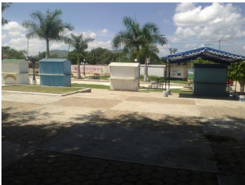
Foto 3: mala distribución de casetas y mal estado de pisos y conexiones. Fuente propia
