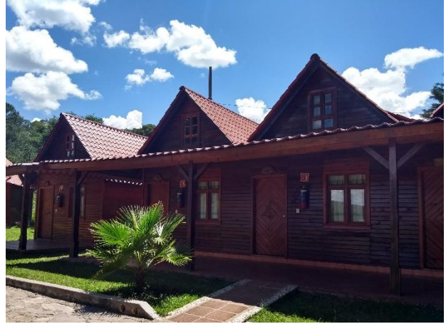
Foto 17: Nave de cabañas, esta nave cuenta con tres cabañas juntas. Fuente propia.
