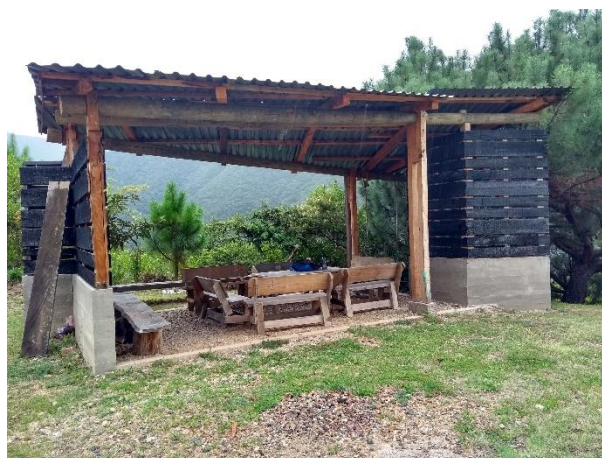
Foto 33: Espacio destinado a comedores y asadores del complejo. Fuente propia.
