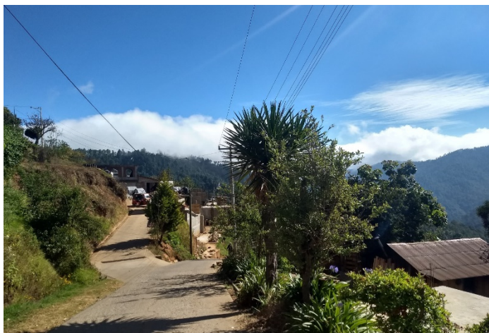
Figura 76. Conexiones de energía eléctrica. Fuente: Fotografía propia, 2019.
