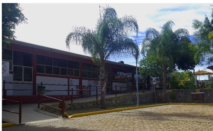
Figura 4. Vista parcial del pasillo que conduce a los salones. Fuente: Fotografía propia, 2019.
