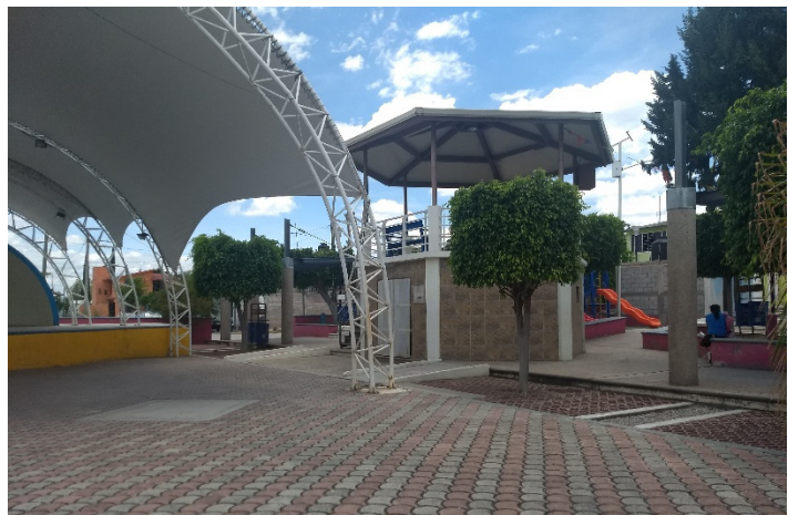
Figura 33. Aplicación de materiales de construcción del Parque Dr. Luis Guevara Camacho. Fuente: Fotografía propia, 2019.
