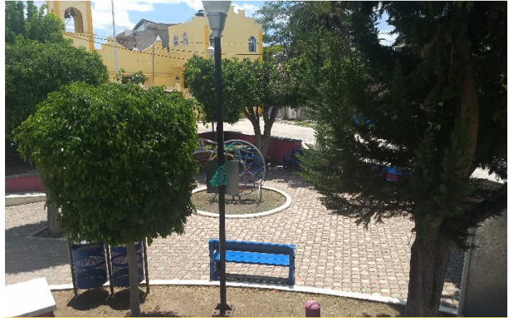
Figura 32. Distribución de luminarias eléctricas en áreas de jardín. Fuente: Fotografía propia, 2019.
