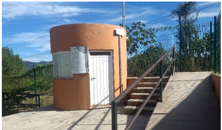
Figura 36. Vista de la entrada principal y módulo de vigilancia Fuente: Fotografía propia, 2019.
