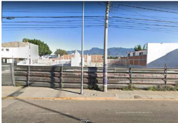
Figura 75. Vista frontal del predio desde la Carretera Internacional. Fuente: Google Maps.
