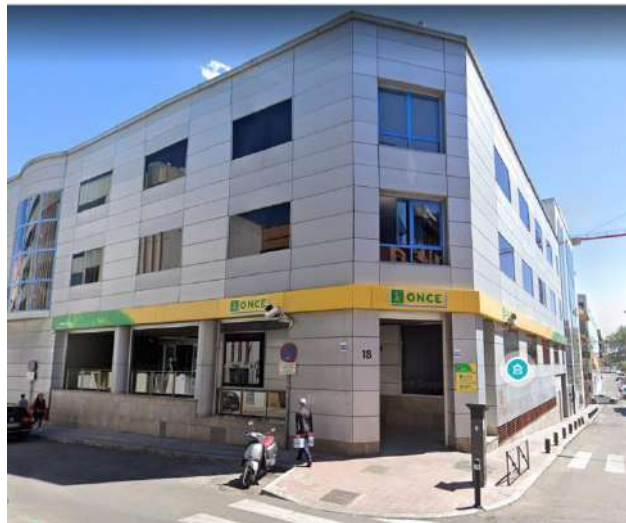
Figura 50. Fachada del edificio del Museo Tiflológico. Fuente: Google Maps
