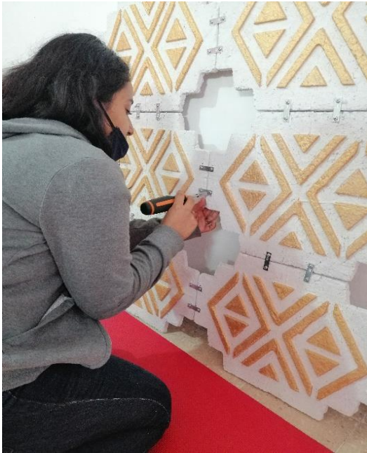
Figura 74. Trama completa en pie, el usuario 3 realiza los ajustes a las pijas para que estén perfectamente atornilladas (Elaboración propia).
