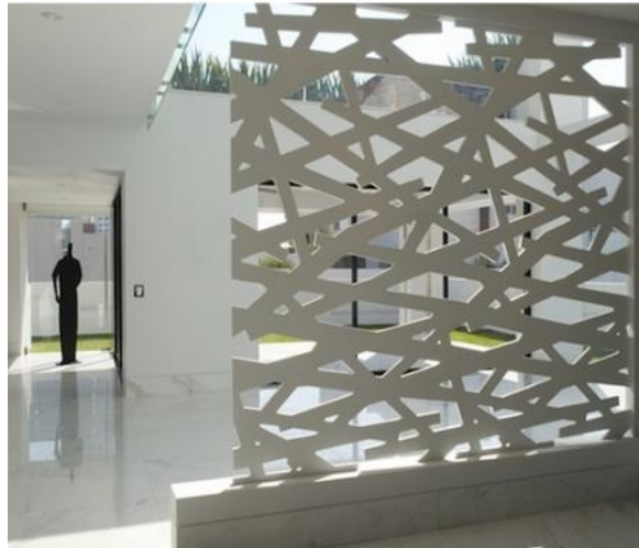
Figura 8. Celosía para interiores fabricada con material Duralmond (Duralmond, 2014).
