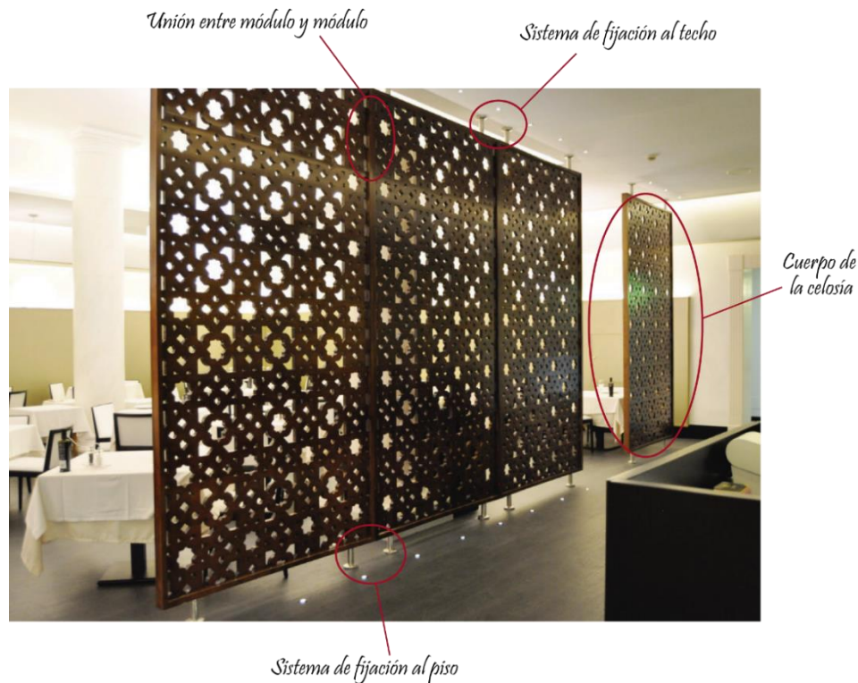
Figura 58. Elementos básicos de la arquitectura de una celosía (Elaboración propia).
