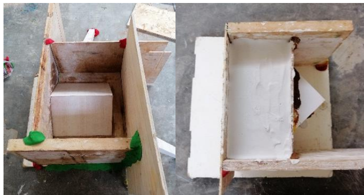
Figura 23. Elaboración de moldes con yeso cerámico para la probeta utilizada en el ensayo de compresión (Elaboración propia).
