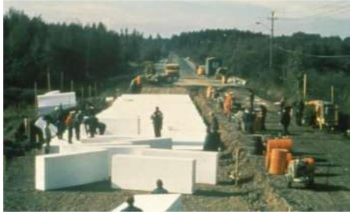
Figura 6 Uso del EPS en construcción de carretera en Noruega.
