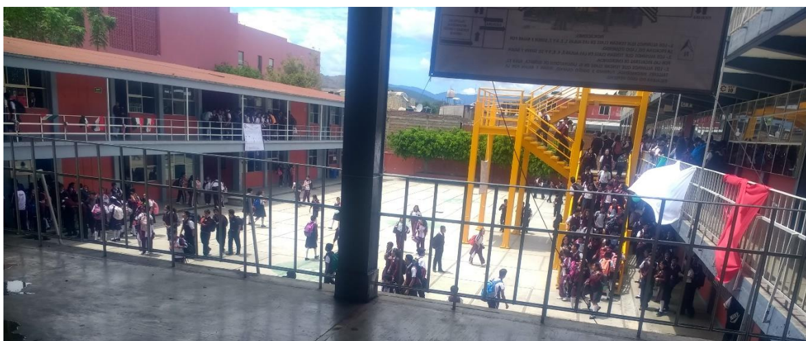
Figura 63. vista de las aulas de la EST No. 1.
