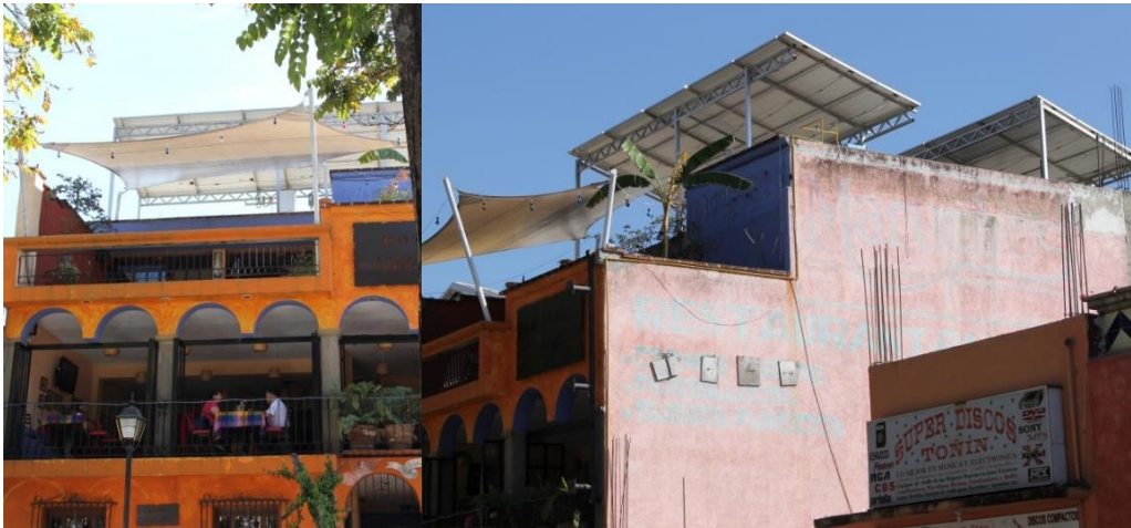
Figura 3 Edificación con la implementación de un sistema fotovoltaico, Huajuapán de León. Fuente propia
