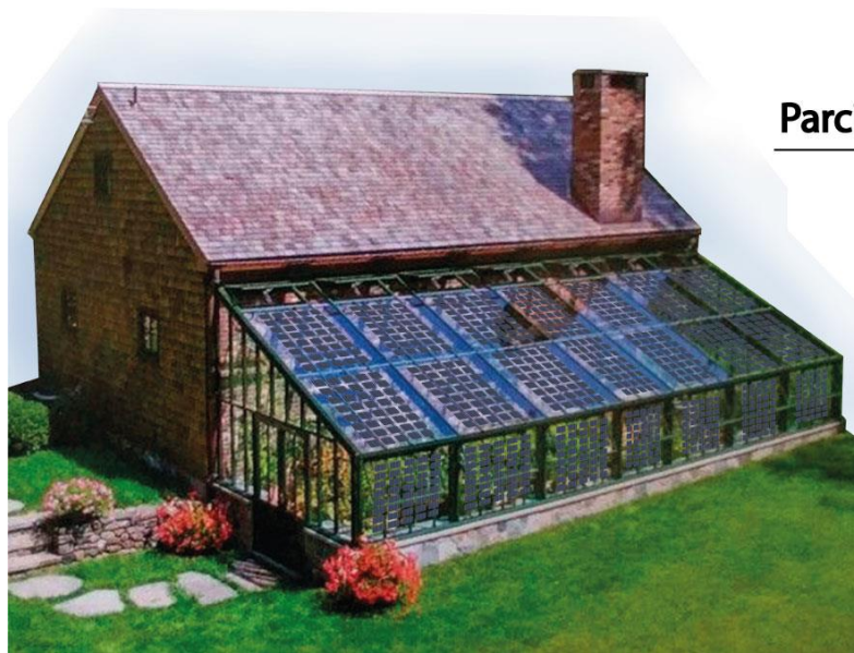
Figura 5 Ventanas fotovoltaicas en lado sur del edificio como espacio parcialmente aislado. Fuente: propia con información del libro "Solar Energy Engineering".
