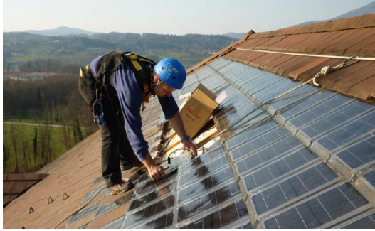
Figura 10 Sistema solar colocado al mismo nivel de la cubierta. Fuente web
