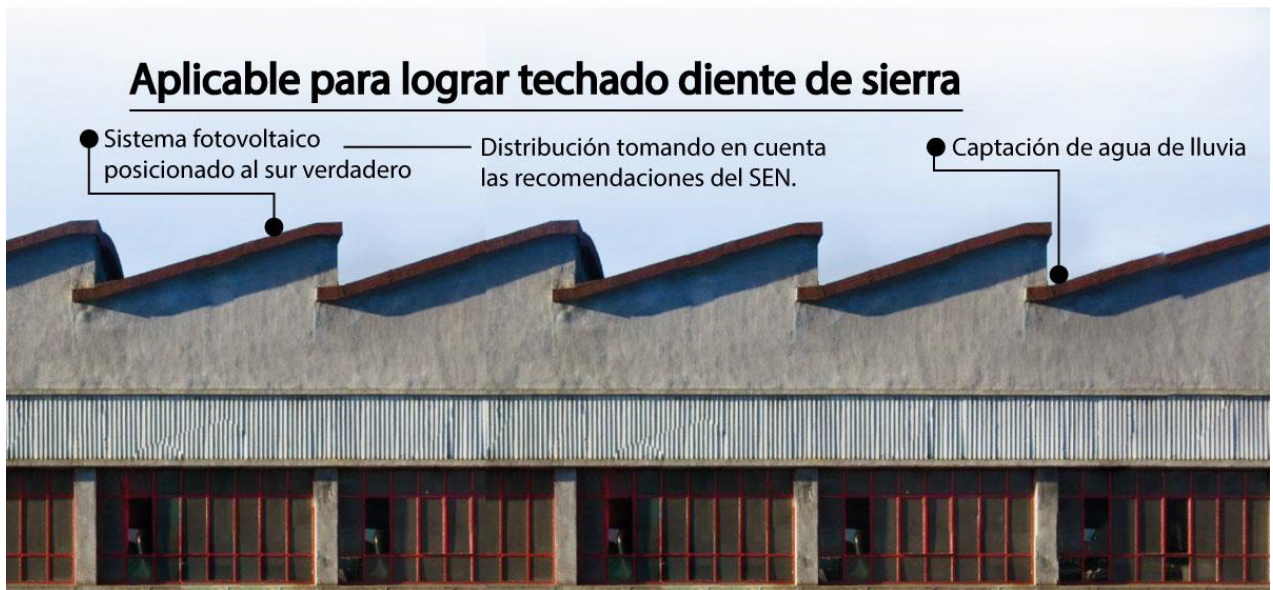
Figura 41 Uso de sistema Fotovoltaico con ventilación, aislamiento o iluminación. Fuente propia
