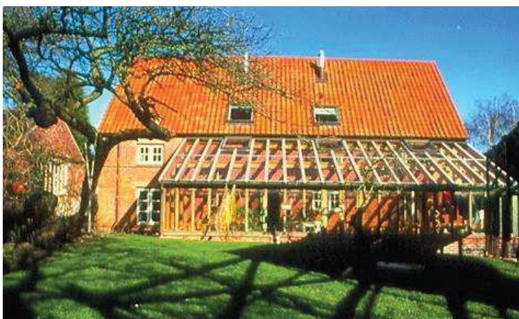
Figura 8. Casa Autónoma de Brenda y Robert Vale. Construida en Southwell, Nottinghamshire, en 1993. Fuente: Ranald Boydell.
