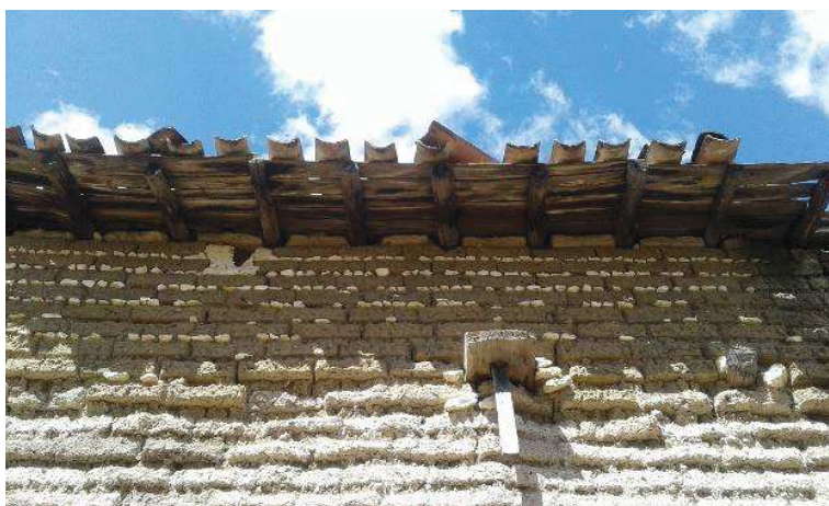
Figura 18. Unión de techo con muro, vivienda vernácula. Sta. Cruz Rancho Viejo, Oaxaca. Fuente: Fotografía del autor.
