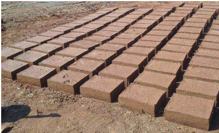
Figura 25. Hileras de adobe en etapa de secado. Fuente: Construcción de Adobes Don Fede.
