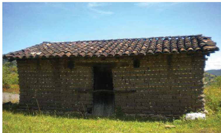
Figura 4. Vivienda tradicional en abandono, construida con adobe. Sta. Cruz Rancho Viejo, Oaxaca. Fuente: Fotografía del autor.
