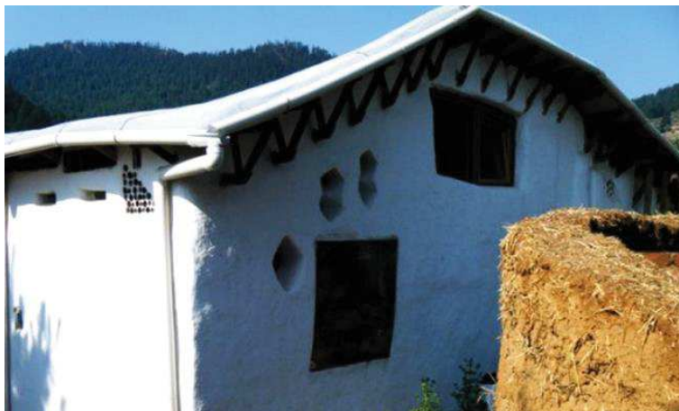
Figura 7. Centro Educativo para el Desarrollo Rural (Ceder), Huixquilucan, Estado de México. Fuente: Grupedsac.
