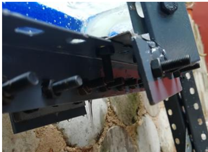
Figura 11. Fuga a falta de hermeticidad.
