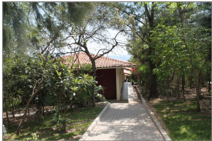
Fotografía 25. Salones de la UTM. Fuente: Fotografía propia
