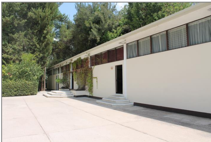
Fotografía 23. Salas de cómputo de la UTM. Fuente: Fotografía propia
