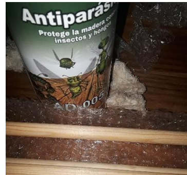
Figura 133. Acabado de madera con antiparásitos
