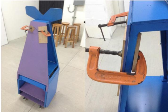
*Fig. 81 Colocación de piezas de trovicel a la estructura, fijándolas con pegamento No más clavos de la marca resistol.*
