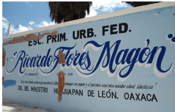
Figura 66: Fachada principal de la Primaria “Ricardo Flores Magón”
