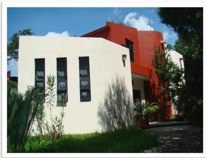
Fotografía 14. Fachada principal del Instituto de Hidrología.
