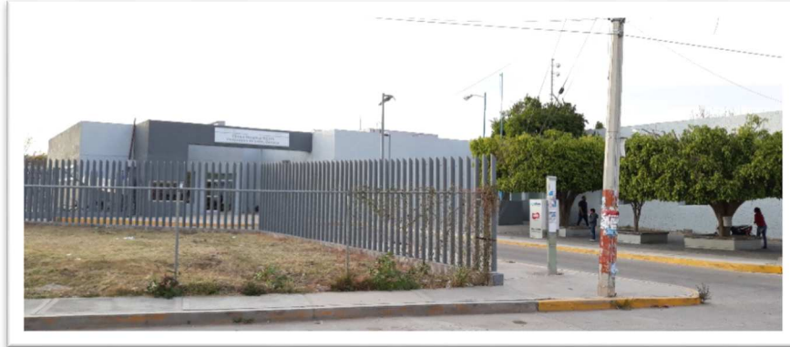
Fotografía 23. Clínica Hospital N° 24 ISSSTE.
