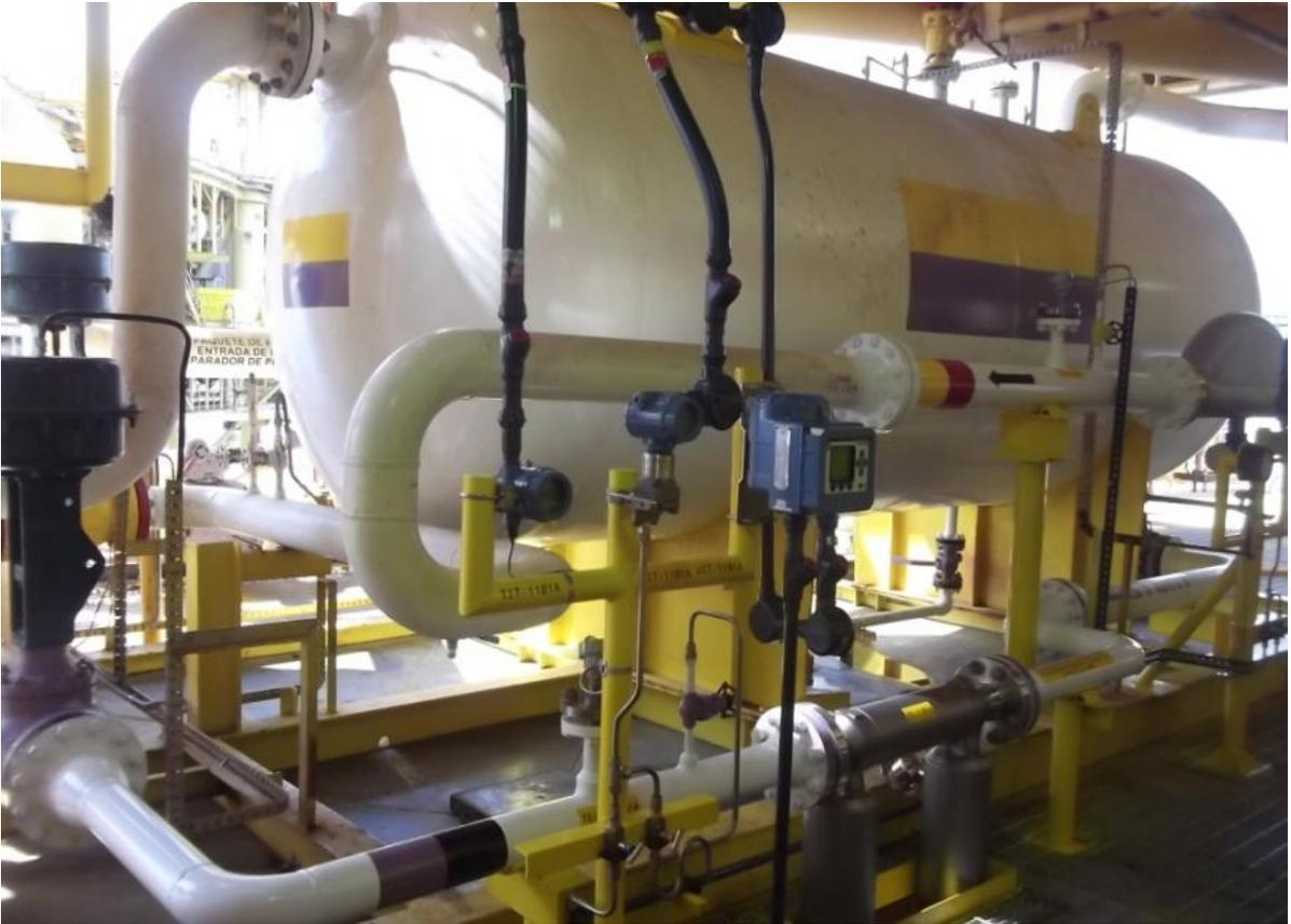
Figura 1.2 Medidor tipo Coriolis instalado en una separación bifásico.
