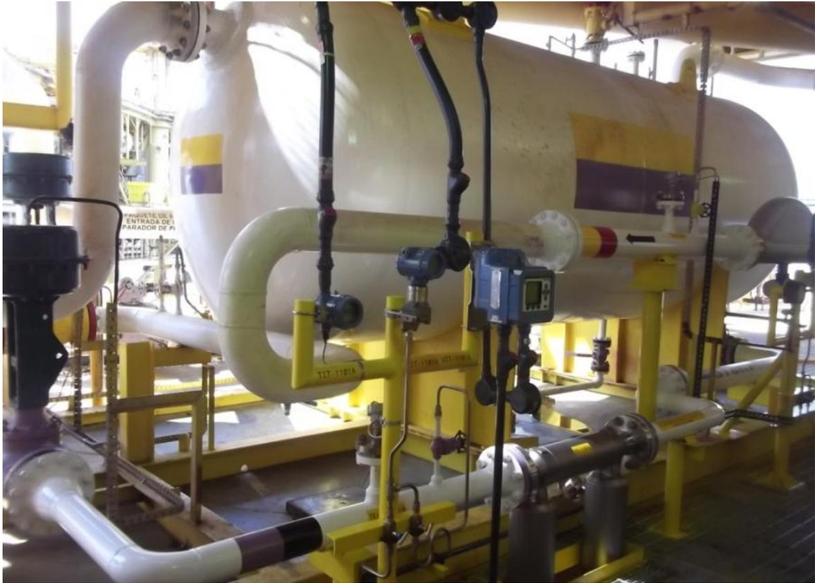
Figura 5.3 Sistemas de medición del separador de prueba FA-1101
