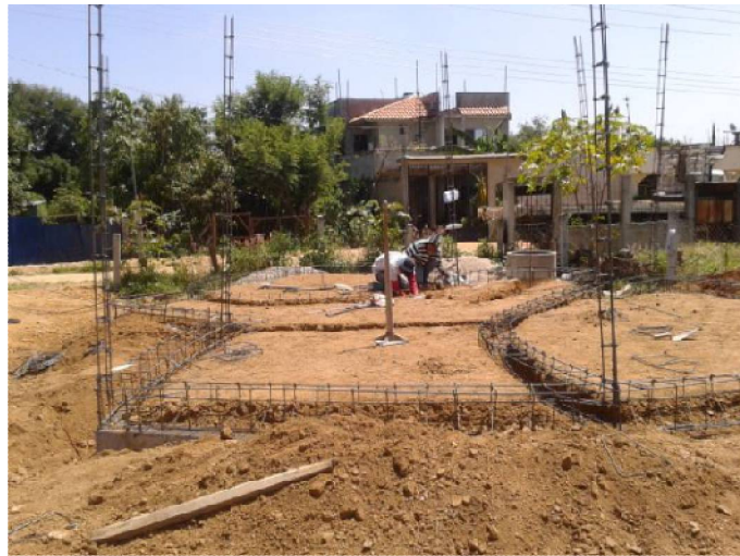
Figura 33. Fotografía de anclado de castillos en cadena de contra-volteo perimetral y central, Casa Odón, Luqueño.
