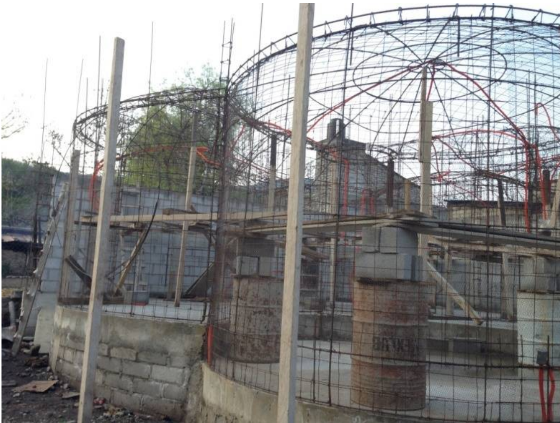
Figura 40. Fotografía del armado de losa tipo cúpula, autoría propia.
