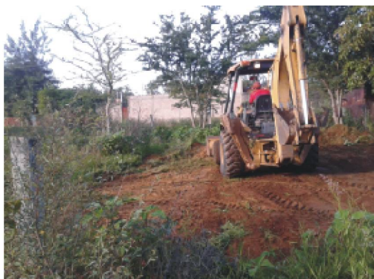
Figura 20. Limpieza con maquinaria.
