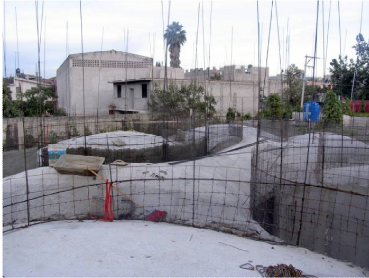
Figura 52. Fotografía de losa de entrepiso, Luqueño.
