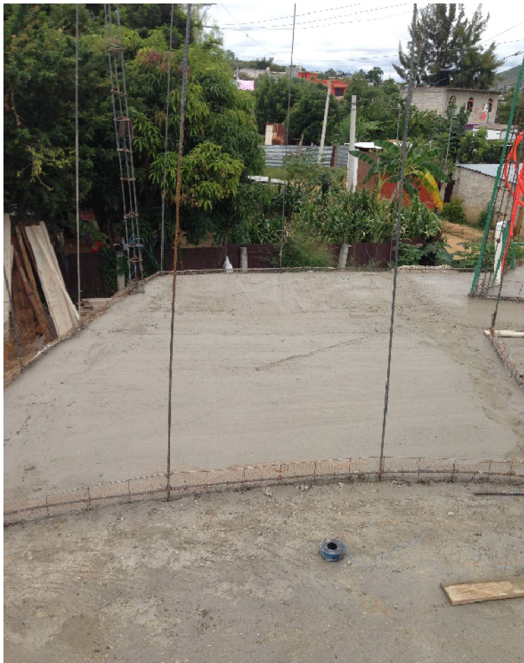
Figura 53. Fotografía de colado de firme de entrepiso, Luqueño.
