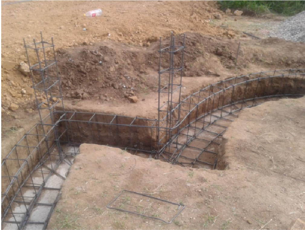
Figura 24. Fotografía armado de zapata y contra-trabe perimetral de Casa Odón, Luqueño.
