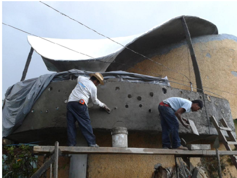
Figura 49. Fotografía de terminado de muro utilizando llana de gauchó, Luqueño.
