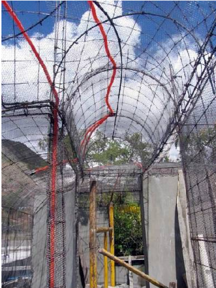
Figura 41. Fotografía de armado de losa tipo media caña, Luqueño.
