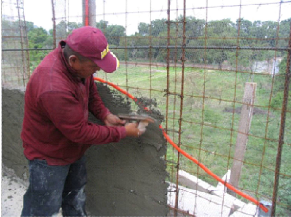
Figura 47. Fotografía de aplicación del mortero en muro utilizando llana de gaucho, Luqueño.
