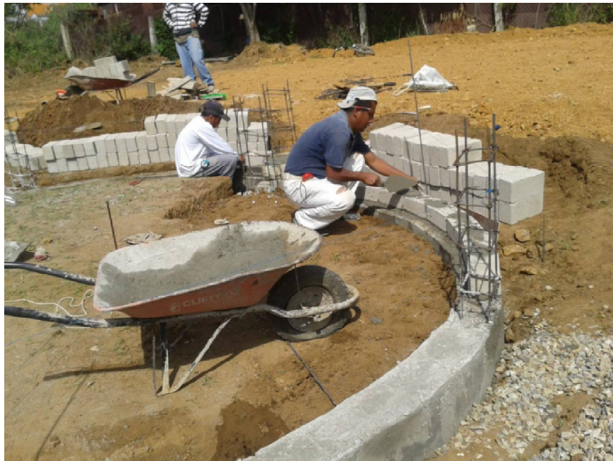
Figura 26. Fotografía de colocación de Muro de enrase sobre la contra-trabe perimetral, Luqueño.
