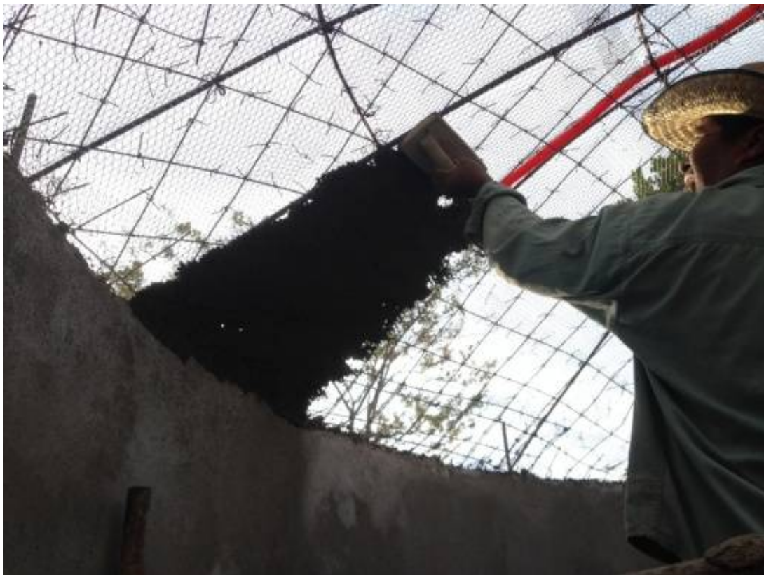
Figura 50. Fotografía de colocación del mortero en losa con llana de gaucho
