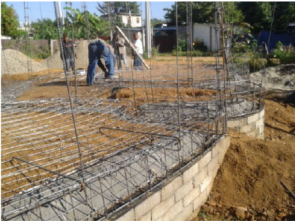
Figura 35. Fotografía de la colocación de bastones como refuerzo de la losa de cimentación, Casa Odón, Luqueño.
