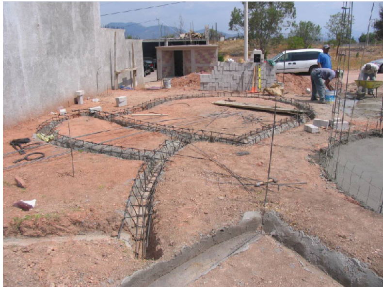
Figura 31. Fotografía de armado de trabe de contra-volteo central, Luqueño.
