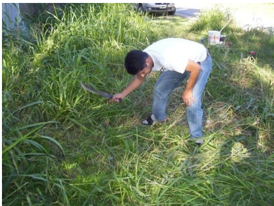
Figura 19. Limpieza de terreno manual.
