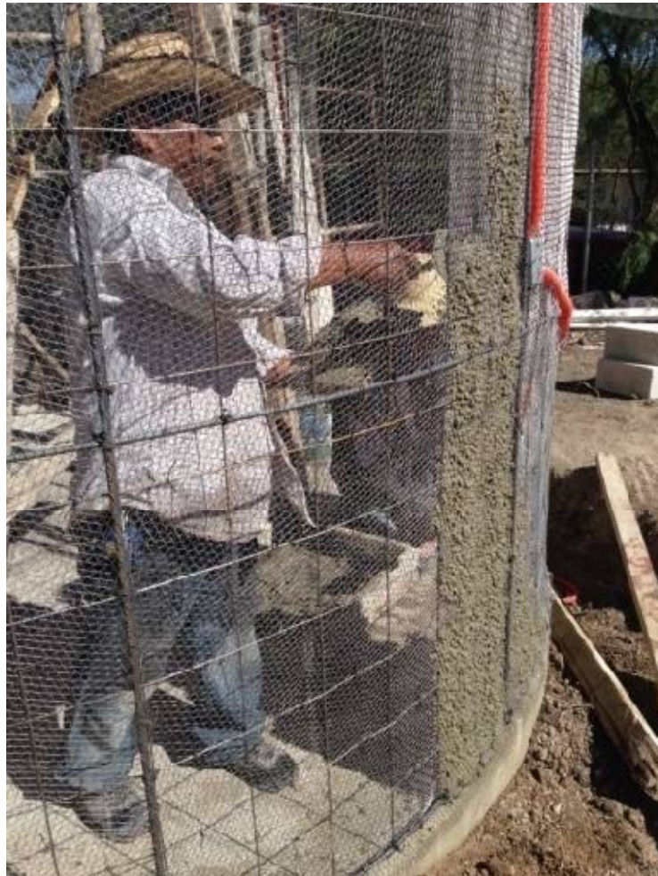
Figura 46. Fotografía de aplicación del mortero con cuchara de albañil, autoría propia.
