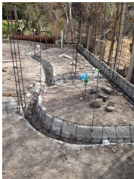
Figura 34. Fotografía de anclaje de varilla vertical en trabes de contra-volteo perimetral y central, autoría propia.
