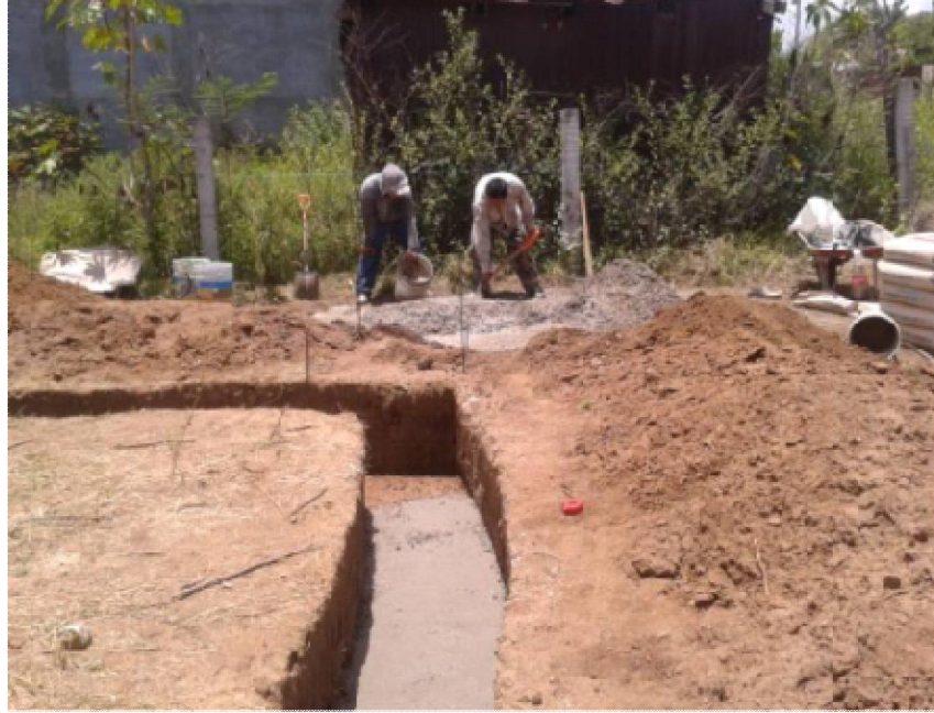
Figura 23. Fotografía plantilla de la zapata perimetral de Casa Odón, Luqueño.
