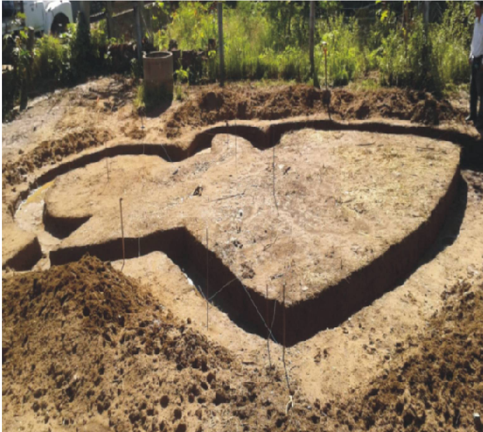
Figura 22. Fotografía de excavación terminada para la cimentación de Casa Odón, Luqueño.
