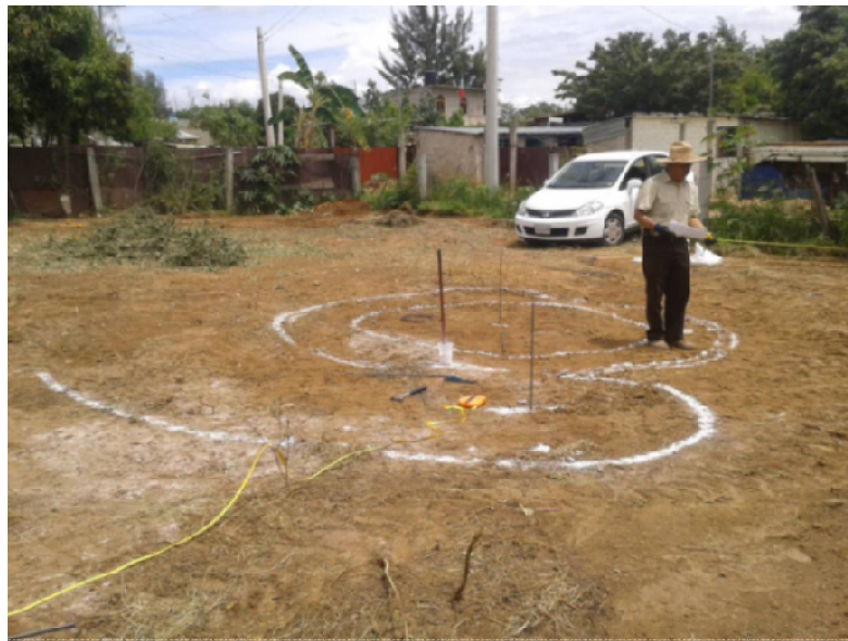
Figura 21. Fotografía trazado de la cimentación, Casa Odón, Luqueño.
