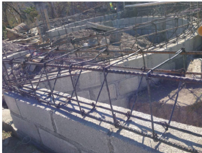
Figura 29. Fotografía de armado de trabe de contra-volteo perimetral, autoría propia.
