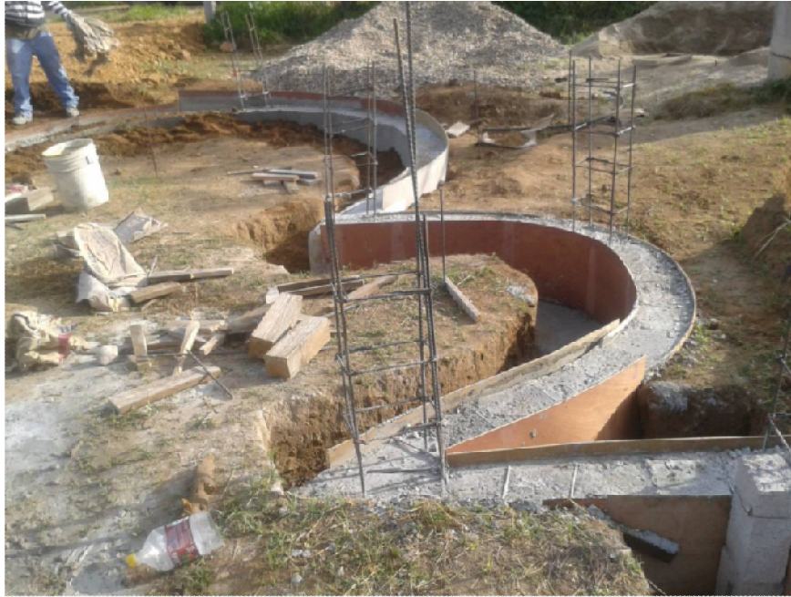
Figura 25. Fotografía de cimbrado con triplay y colado de contra-trabe perimetral, Luqueño.
