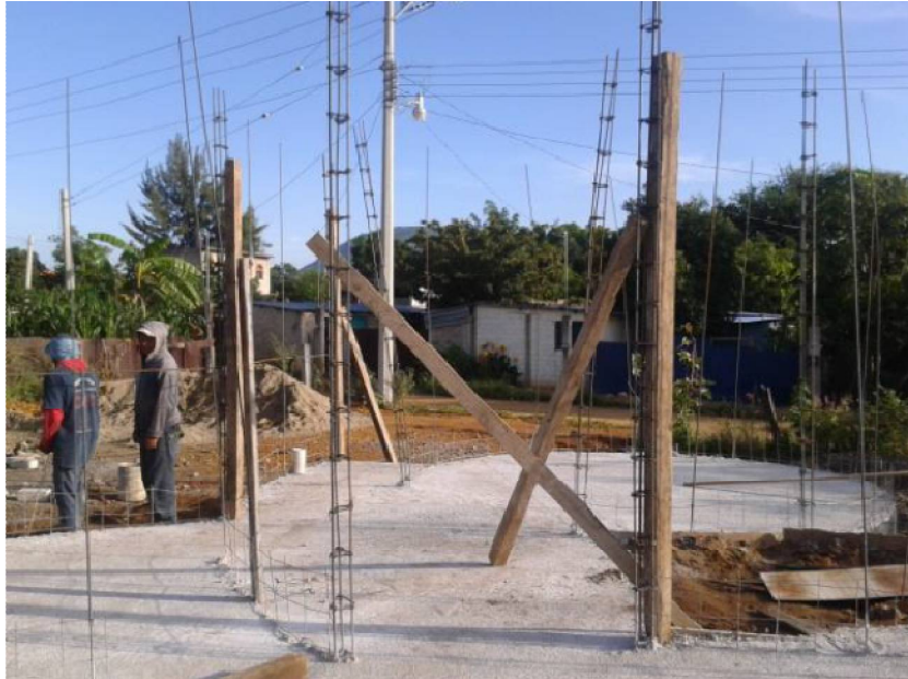
Figura 38. Fotografía de losa de cimentación colada, Luqueño.
