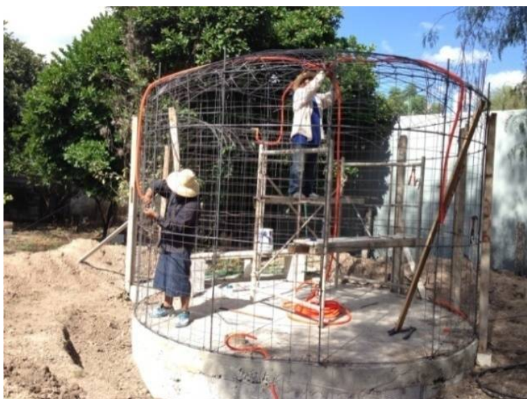
Figura 42. Fotografía de la colocación de los ductos para instalación eléctrica, autoría propia.
