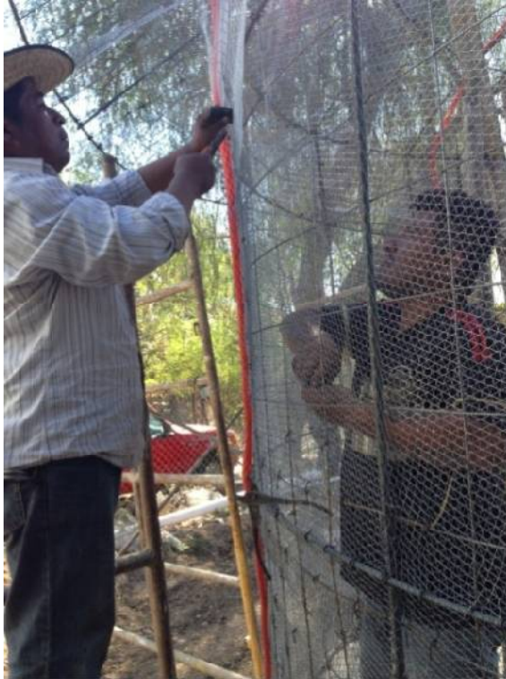
Figura 44. Fotografía del Engrapado de muro, autoría propia.
