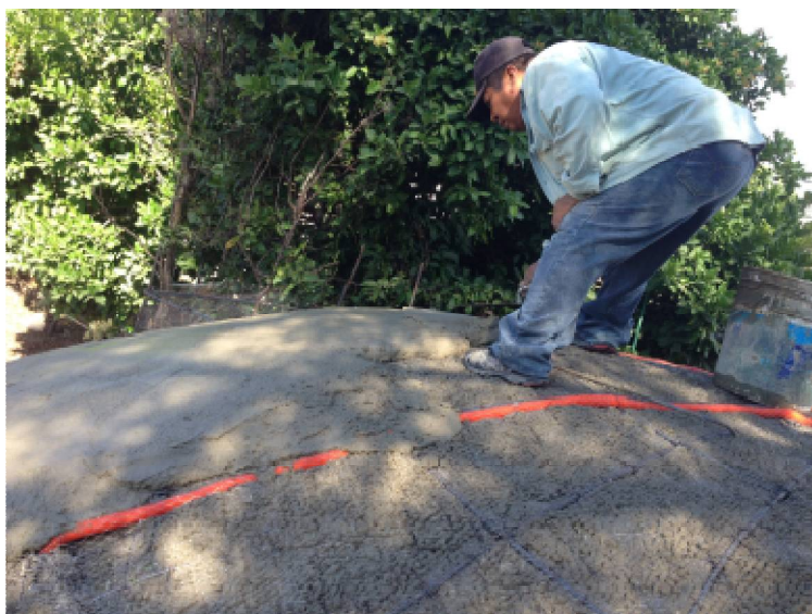
Figura 51. Fotografía del colado de losa con mortero, autoría propia.
