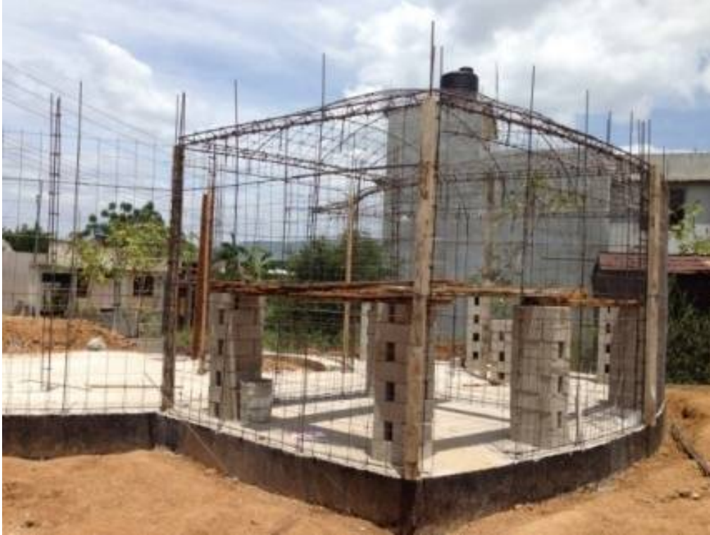
Figura 39. Fotografía del armado de muros de ferrocemento, Casa Odón, Luqueño.
