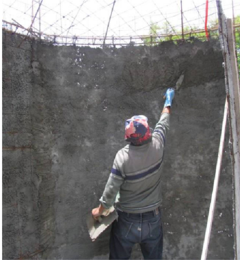
Figura 48. Fotografía de aplanado de muro, Luqueño.
