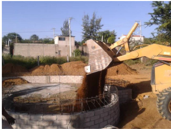
Figura 27. Relleno del área utilizando maquinaria, Casa Odón, Luqueño.
