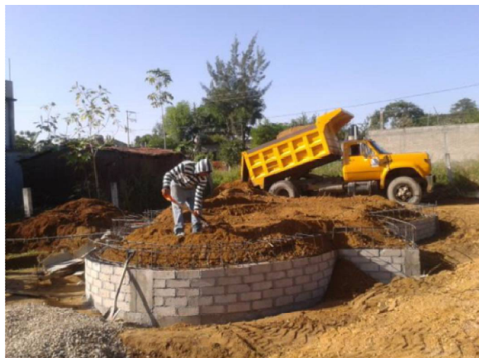
Figura 28. Fotografía compactación manual del relleno, Casa Odón, Luqueño.
