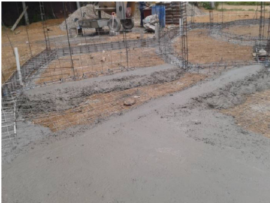
Figura 37. Fotografía de colado de losa de cimentación, Luqueño.
