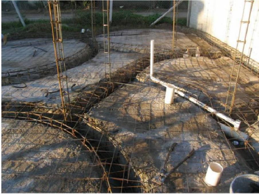
Figura 36. Fotografía colocación de instalación Sanitaria, Luqueño.
