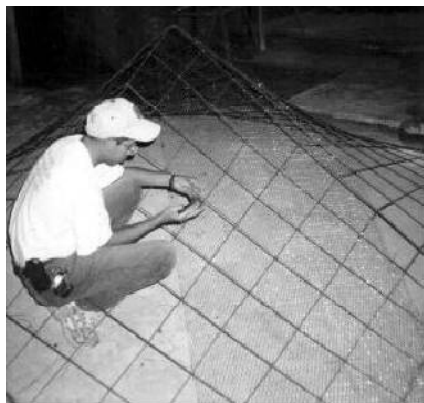
Figura 3. Armado de techo, Mejía (2005)
