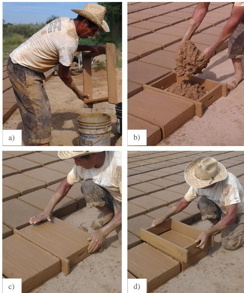
Fig. 1.3.3.1. Proceso de elaboración de adobes. Realizada la mezcla de los materiales y su reposo, a) Se prepara el molde humedeciéndolo antes de utilizarlo. b) Se coloca el molde y se vacía la mezcla con fuerza y cuidando de no dejar espacios vacíos. c) Se empareja la parte superior con la mano o con una regla de madera. d) Se desmolda moviendo el marco de lado a lado y se deja secar el adobe obtenido. Fuente: El tesista.
