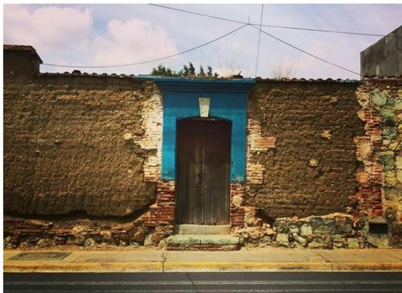
Fig. 1.1.2. Baja resistencia a la abrasión, a la compresión y a flexión. Fuente: El tesista.
