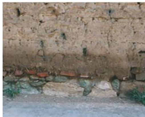
Fig. 1.1.3. Baja resistencia al agua. Fuente: Alavéz, 2012.
