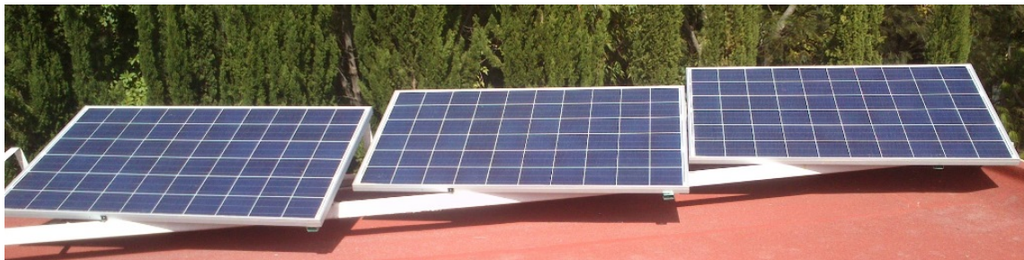
Figura 6.21: Paneles solares fotovoltaicos instalados.
