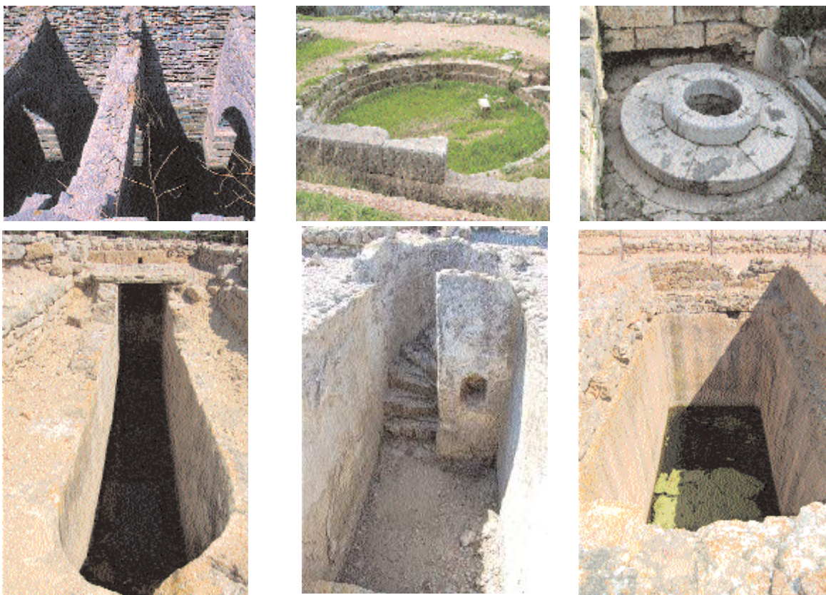
Imagen 2.5 Depósitos como la cisterna de la isla Delfos en Grecia (arriba izquierda), la cisterna circular de Delfos (arriba centro), el pozo de Calícaros en Eleusis (arriba derecha) o las cisternas de formas variadas (fotos inferiores).
