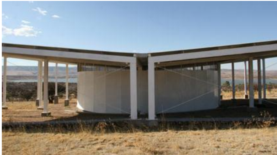
Imagen 3.2 Techo cuenca implementado en el estado de Aguascalientes.
