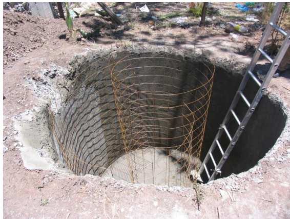
Imagen 5.22 Forjado de tierra para tanques enterrados.
