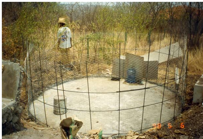
Figura 3.10 b) Tanque de ferrocemento superficial.
