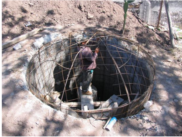
Imagen 5.23 Armado de la estructura.
