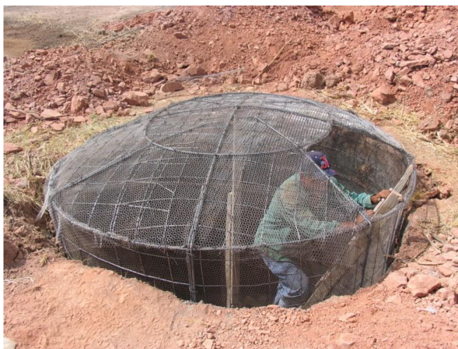
Figura 3.10 a) Tanque de ferrocemento enterrado.
