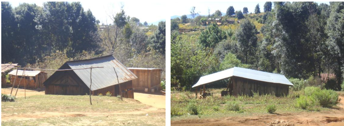
Imagen 4.13 a) Se muestran los materiales con los que se encuentran construidas las viviendas y la distribución de las construcciones. b) Los techos son a una o dos aguas.
