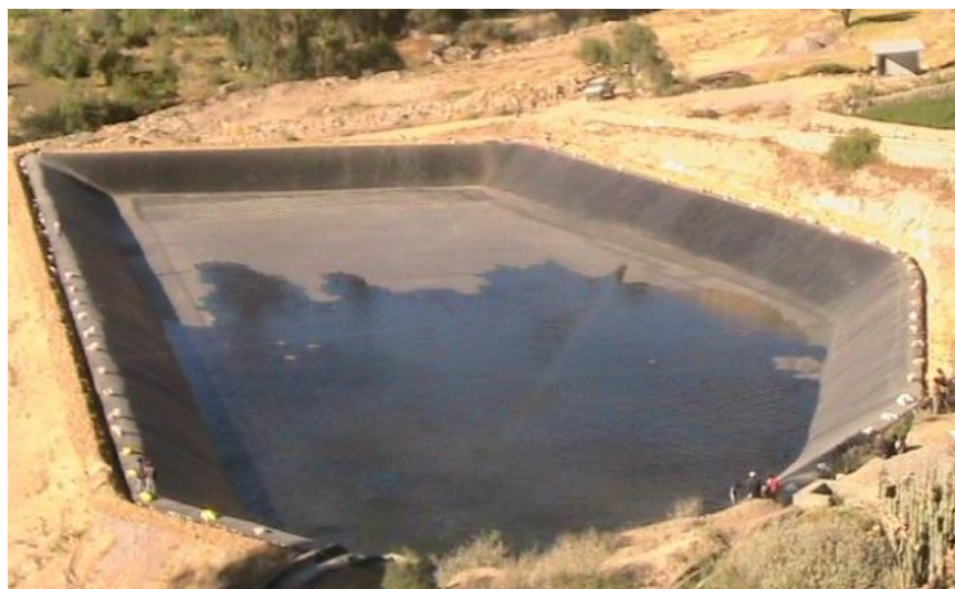
Imagen 3.3 Geomembrana. La forma está determinada por la topografía y puede ser variada dependiendo de la cantidad de agua a recolectar. Se implementa para beneficio de toda una comunidad.
