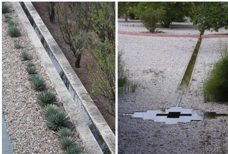
Imagen 2.4 Canales que conducen el agua hasta cada una de las áreas del jardín etnobotánico. La imagen muestra como se encuentran actualmente los canales, ya que fueron modificados cuando se acondicionó el jardín etnobotánico.
