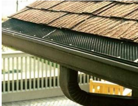
Imagen 3.9 Canaleta con malla.
