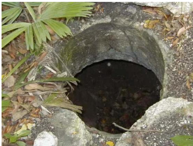
Imagen 2.8 Exterior de un Chultún. En la parte inferior de la imagen se puede apreciar un canal por el cual llegaba el agua hacia la boca del chultún, el área periférica destinada para la captación del agua de lluvia se mantenía libre de vegetación.
