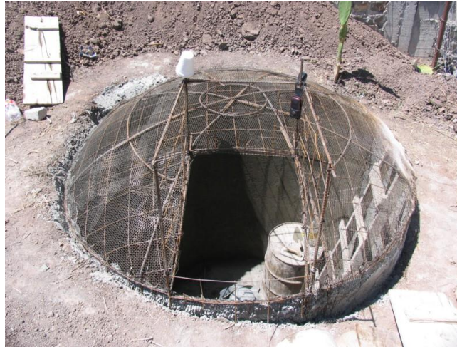
Imagen 5.24 Aplicación del mortero.
