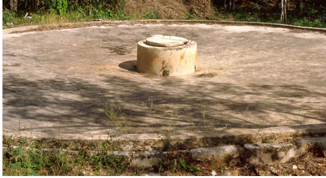
Imagen 2.3 Chultún. Ubicado en el Estado de Yucatán, se puede apreciar el exterior y el área especialmente preparada para captar el agua, con cierta inclinación de tal forma que el agua era conducida hacia el centro para almacenarla.
