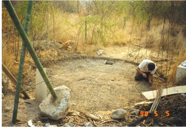
Imagen 5.21 Base para tanque superficial.
