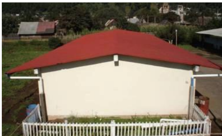
Imagen 3.1 Techo de escuela utilizado como área de captación.
