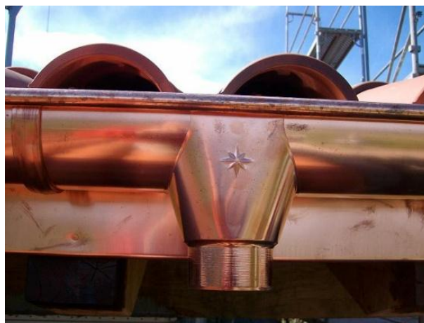
Imagen 3.6 Canaleta de cobre.
