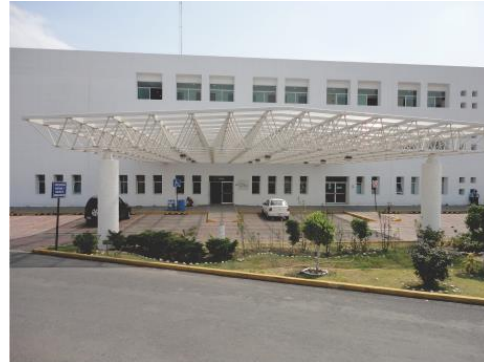
Imagen 17 Fachada lateral, Hospital General Zona Norte de Puebla.
