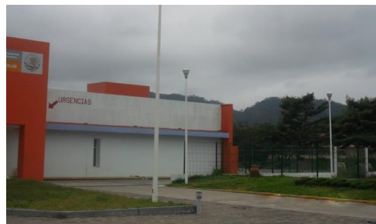
Imagen 2 Acceso a ambulancias, Hospital Básico Comunitario de San Miguel Solyaltepec.
