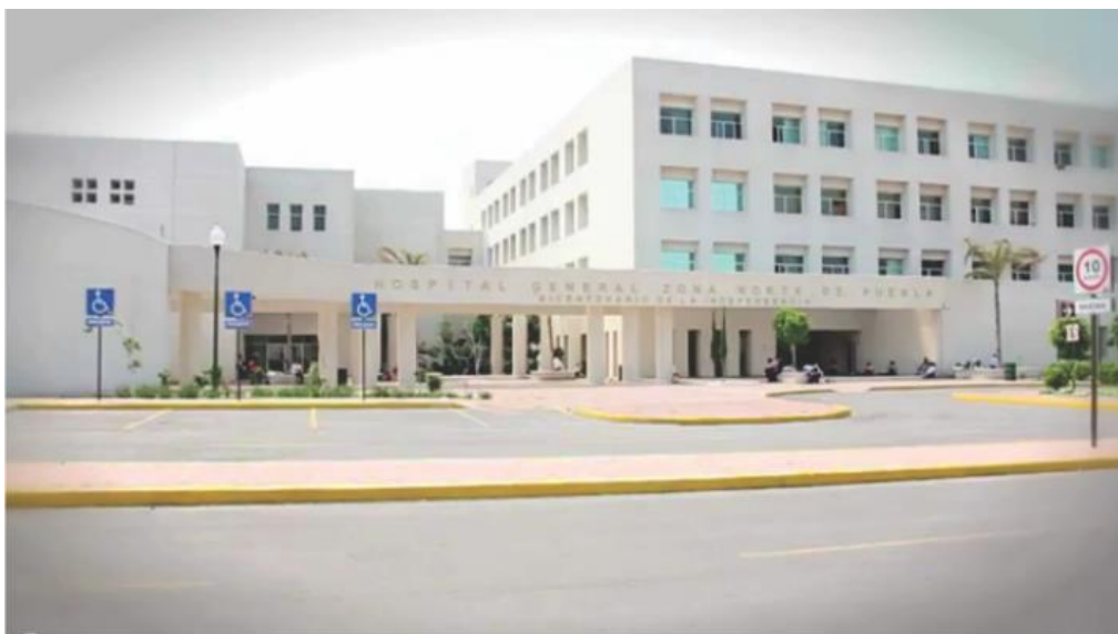
Imagen 16 Fachada Principal, Hospital General Zona Norte de Puebla.
