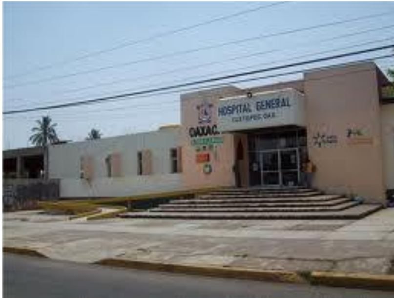
Imagen 9 Fachada principal, Hospital General de Tuxtepec, Oaxaca.
