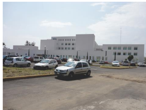
Imagen 18 Fachada posterior, Hospital General Zona Norte de Puebla.
