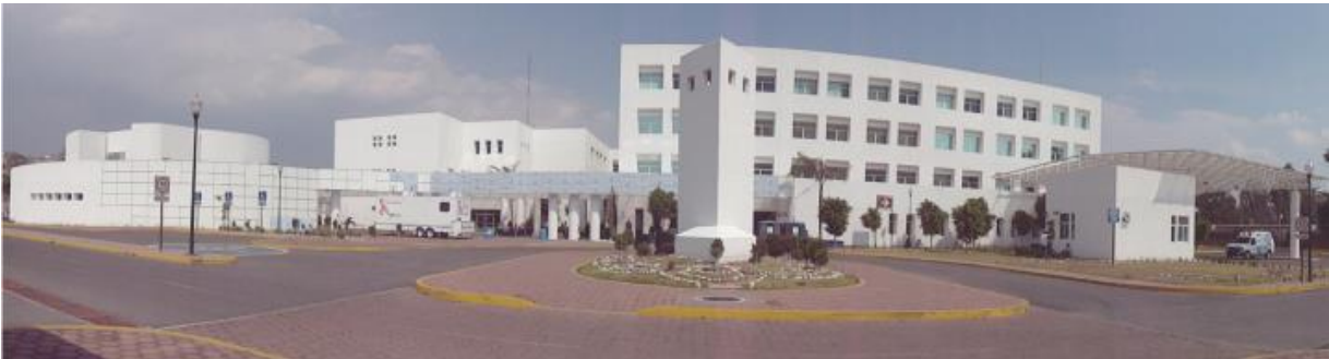
Imagen 15 Entrada principal, Hospital General Zona Norte de Puebla.
