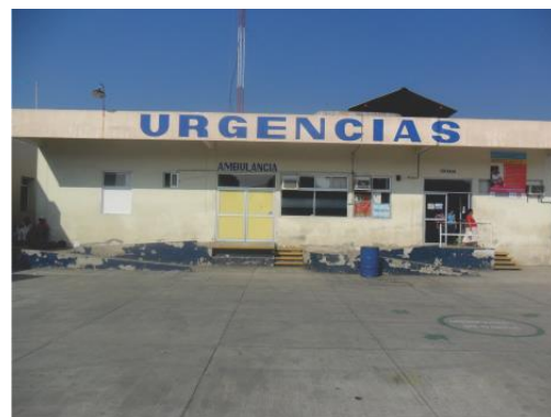
Imagen 10 Acceso a ambulancias, Hospital General de Tuxtepec, Oaxaca.
