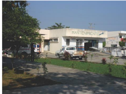
Imagen 11 Área de mantenimiento, Hospital General de Tuxtepec, Oaxaca.
