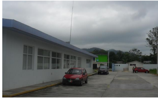
Imagen 3 Acceso a Estacionamiento, Hospital Básico Comunitario de San Miguel Solyaltepec.
