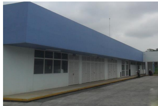
Imagen 8 Edificio de mantenimiento, Hospital Básico Comunitario de San Miguel Solyaltepec.
