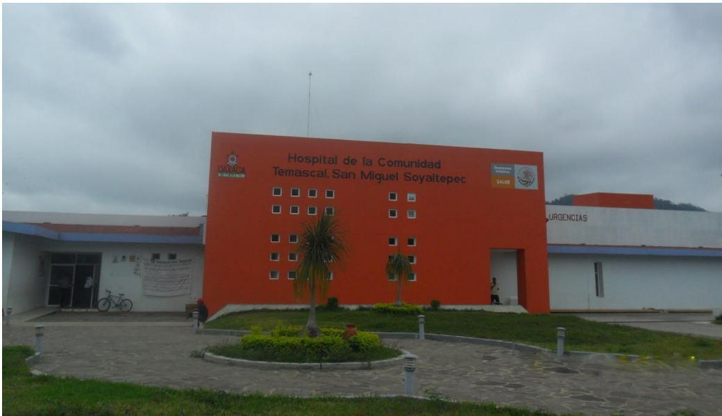
Imagen 1 Fachada principal, Hospital Básico Comunitario de San Miguel Solyaltepec.
