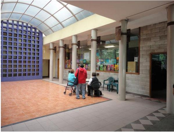
Con el fin de que el usuario se sienta en contacto con la naturaleza, se hace uso de cubiertas de policarbonato por las cuales pasa una menor cantidad de luz, evitando el contacto directo con el sol.
