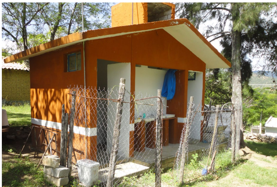
Fotografía 49.- Sanitarios públicos en la comunidad de Rosario Nuevo
