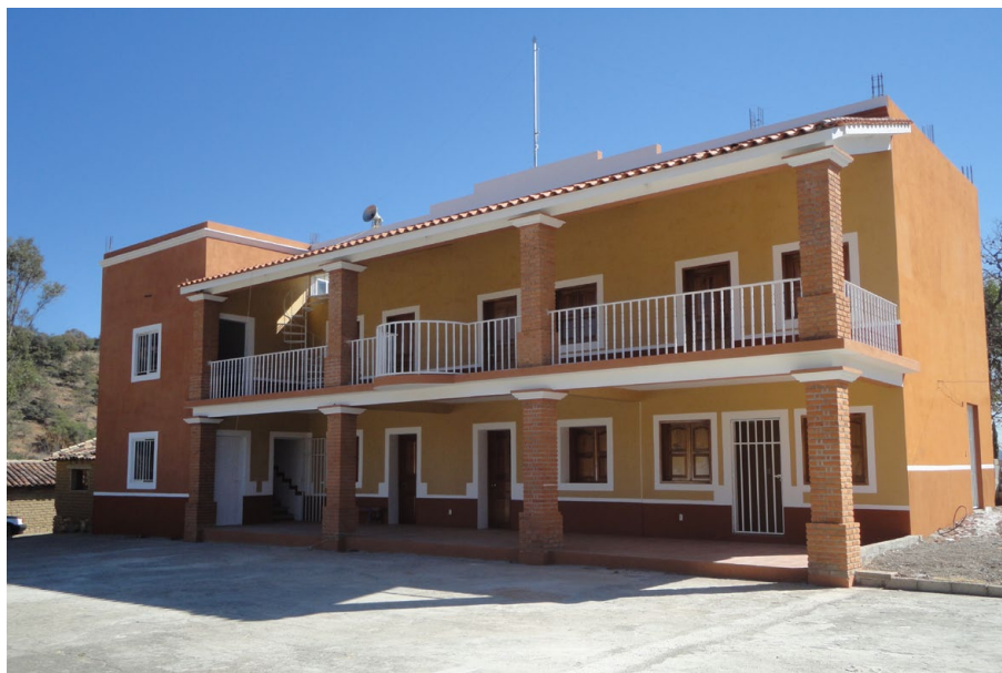
Fotografía 51.- Edificio de la Agencia Comunitaria de la comunidad de Rosario Nuevo.
