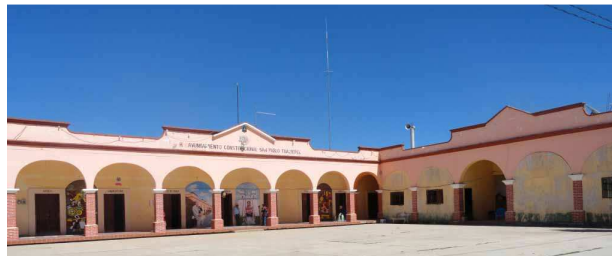
Figura 77. Palacio Municipal de San Pablo Tijaltepec.
