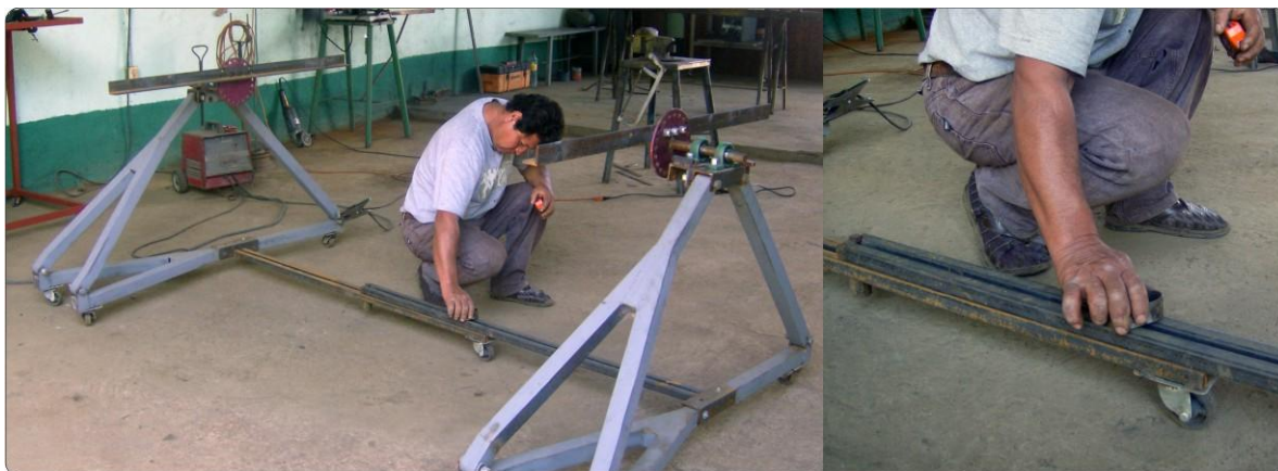
FIGURA 54. Implementación del Puente Extensible
