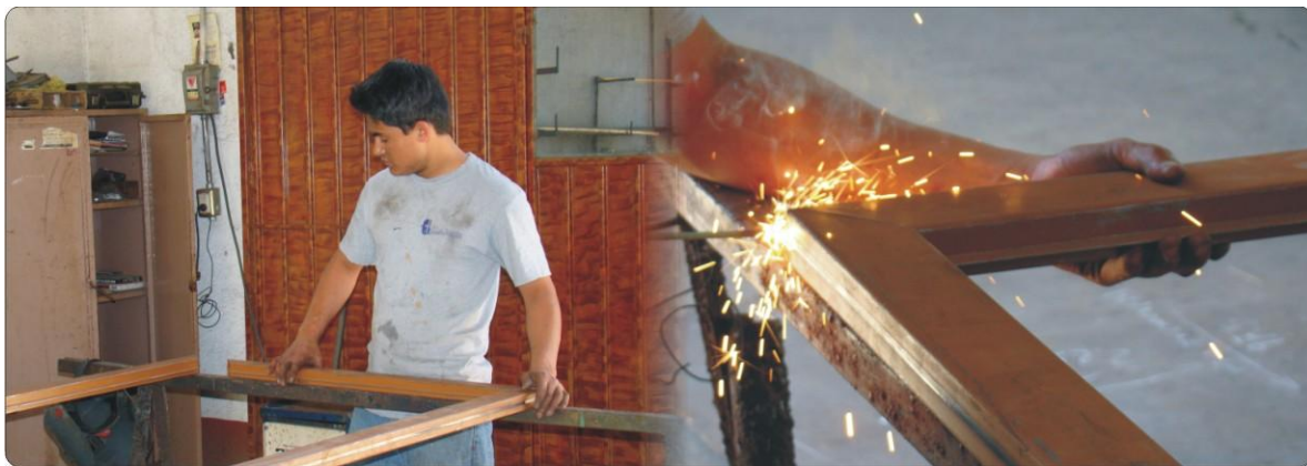
FIGURA 13. Armado y punteado de perfiles metalicos
