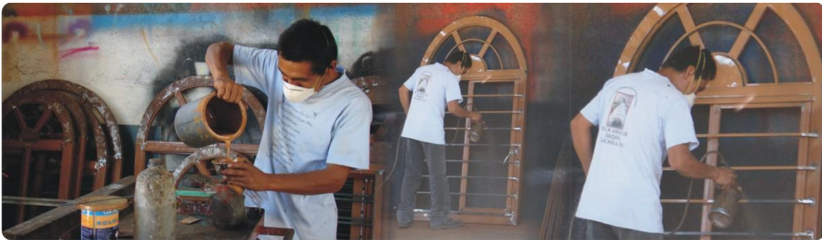
FIGURA 14. Pintado de una estructura
