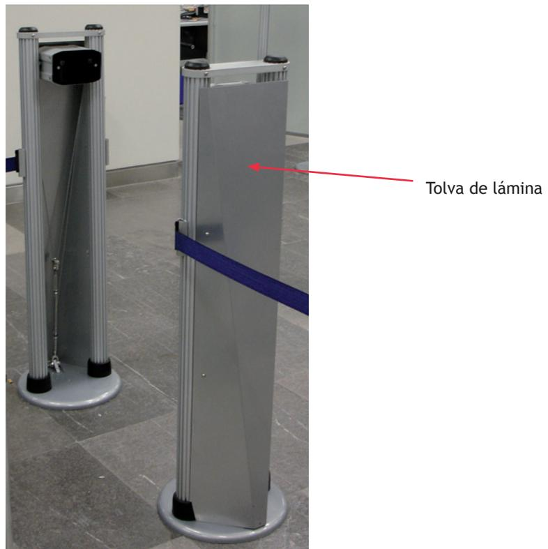
Fig. 37. Tolva de lámina instalada para ocultar cable de acero y tensor
