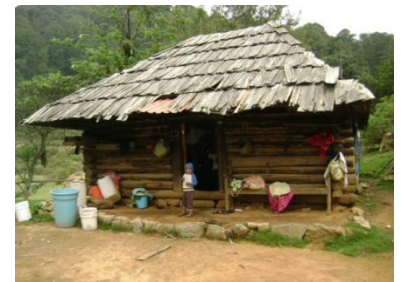
Ilustración 2.15 Casa de madera, Guerrero, Sta. Cruz Itundujia
