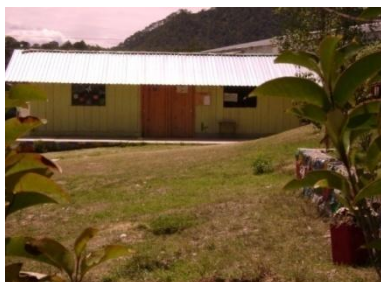
Ilustración 1.21 Vista del aula de madera
