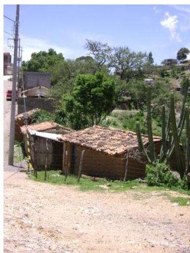
Ilustración 2.16 Viviendas del municipio
