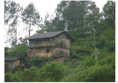
Ilustración 2.9 Casa construida con material típico de Guerrero, Sta. Cruz Itundujia
