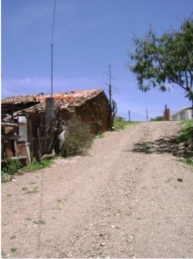
Ilustración 4.25 Calle sin pavimentar
