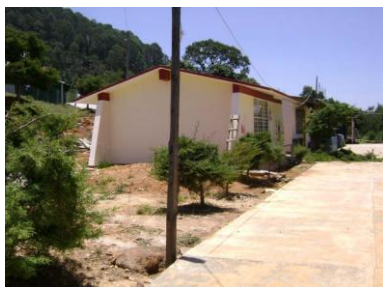
Ilustración 1.14 Vista de las aulas desde el acceso
