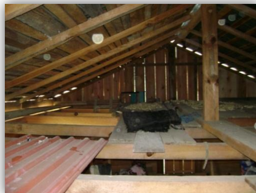
Ilustración 2.11 Recamara de una casa de Guerrero, Sta. Cruz Itundujia
