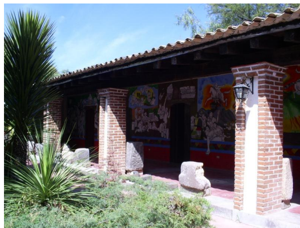
Fotografía 8. Vista de la fachada principal del museo comunitario en Tequixtepec
