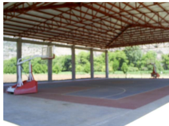
Fotografía 19. Vista interior del Auditorio Municipal
