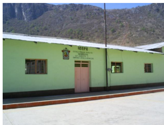
Fotografía 17. Edificio de la Primaria General "Morelos"
