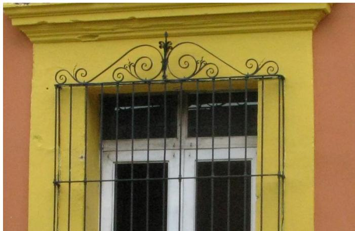
Figura 46. Reja de barras y soleras con motivo de doble espiral.
