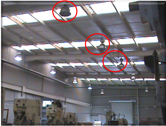
Fig. 4.2 Lámparas que no funcionan Fuente: Elaboración propia
