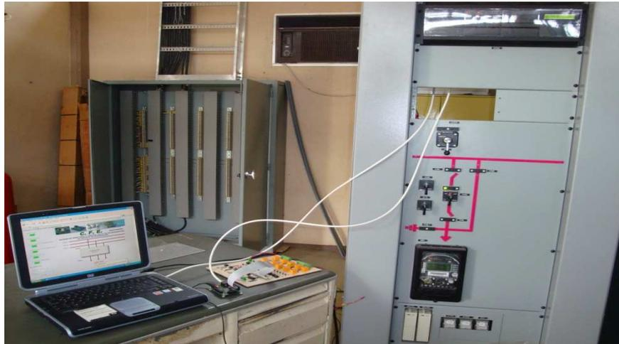
**Figura 4.11** Conexión del sistema al tablero de control del interruptor y la red de intranet de CFE, para realizar las pruebas de monitoreo y control vía IP.
