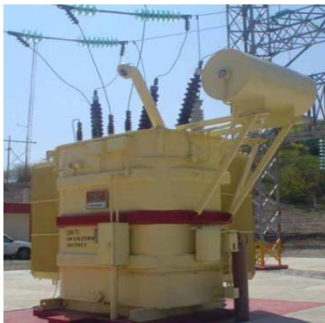
**Figura 2.2** Transformador de potencia.
