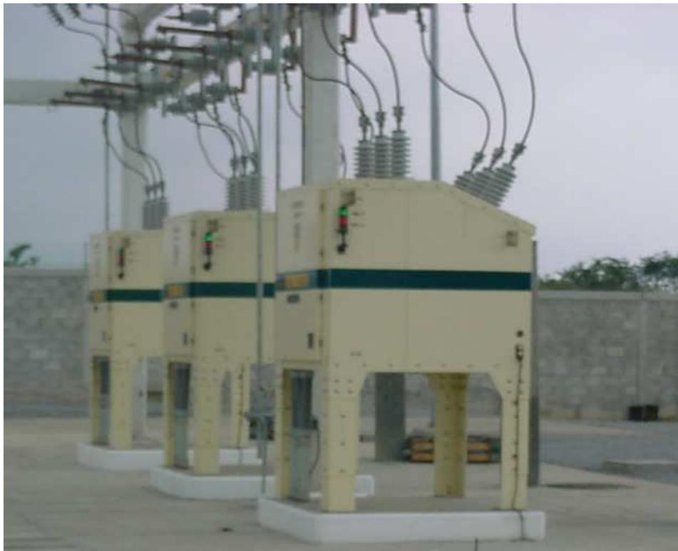
**Figura 2.3** Interruptores de circuitos de distribución (Media Tensión).
