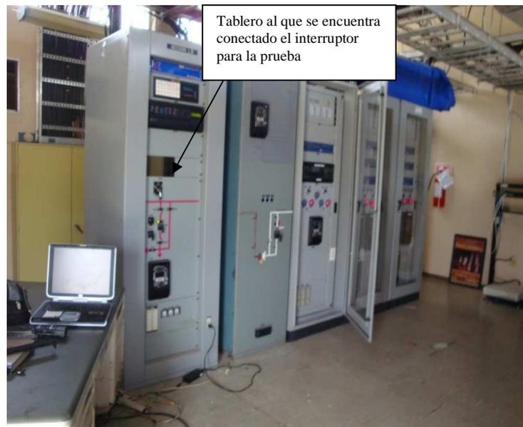
**Figura 4.9** Interior de la caseta de control de la subestación Tlaxiaco.
