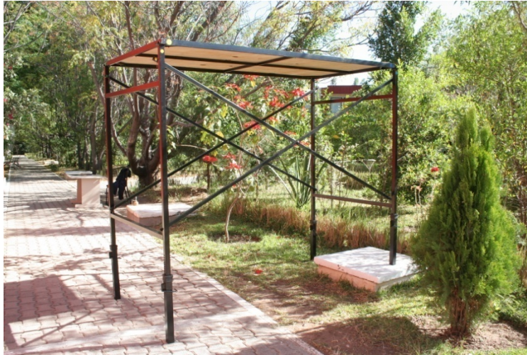
Figura 4.42 El módulo fue ensamblado en desnivel.
