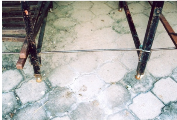
Figura 2.13. Detalle de los tramos de redondo que separan las bases.
