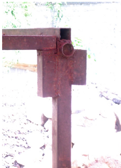
Figura 2.10. Vista de un ensamble entre perfiles rectangulares.
