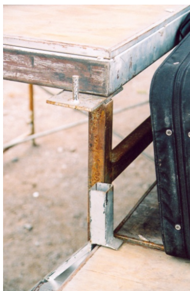
Figura 2.4. Detalle de la pieza de ensamble, la cual cuenta con sólo dos postes.
