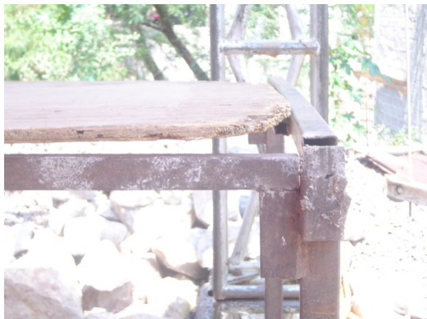
Figura 2.9. Las hojas de triplay usadas no están enmaradas en los perfiles metálicos.
