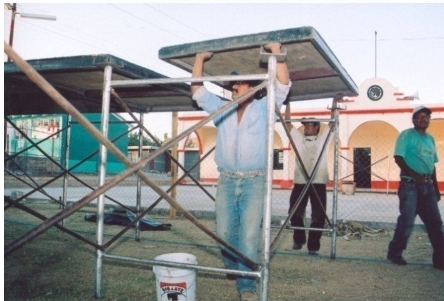
Figura 2.6. Operarios colocando bastidores sobre las bases ensambladas.
