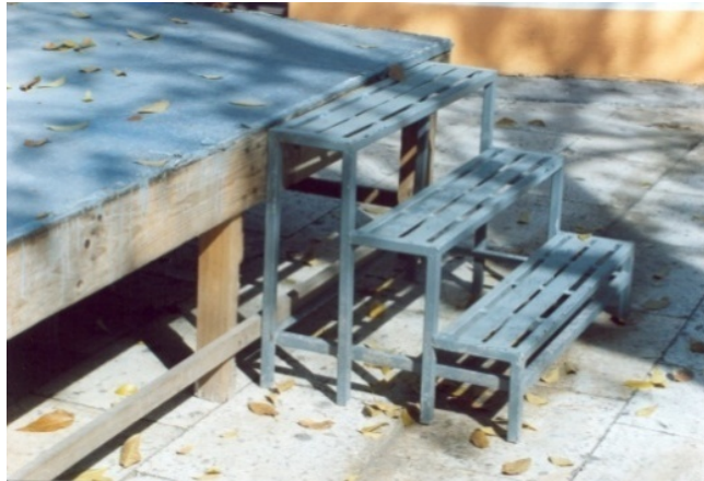
Figura 2.11. En este caso se usa una escalera metálica.
