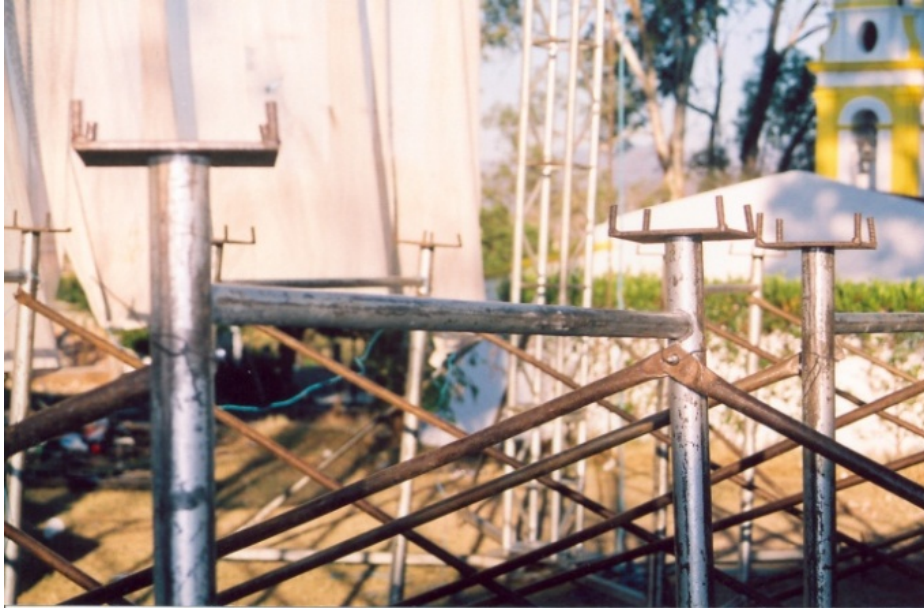
Figura 2.5. Colocación de los ensamblados.
