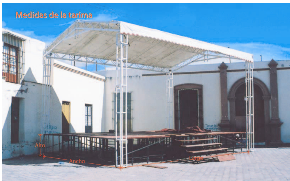
Figura 2.22. Ubicación de las medidas en el conjunto de la tarima.
