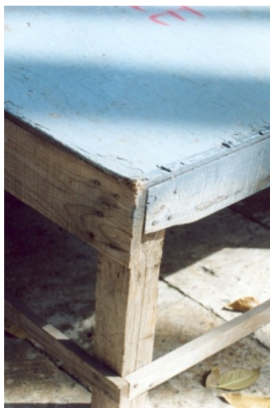
Figura 2.12. Detalle de la esquina del módulo donde se usan clavos para unir los materiales.
