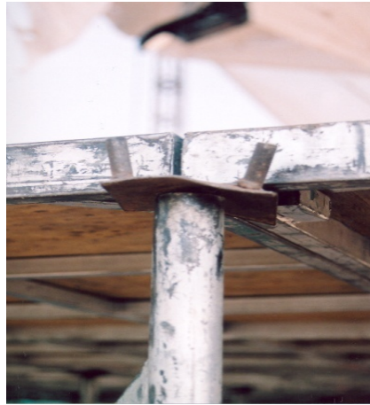
Figura 2.8. El ensamble que recibe los marcos tiene dobladas las puntas.
