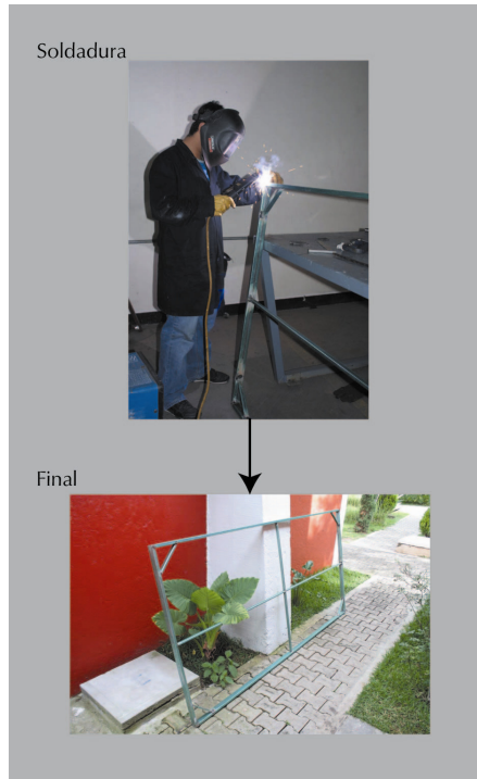
Figura 4.30. Detalles de la construcción del bastidor.
