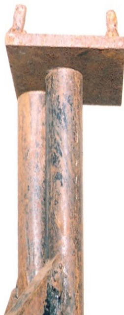
Figura 2.2. Pieza de ensamble del sistema de tarima, llamada “cuerno”.
