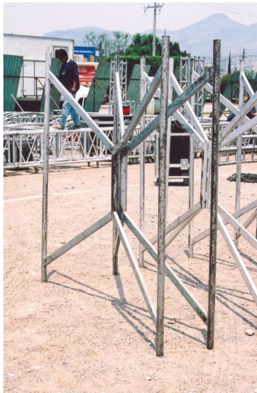
Figura 2.7. Los apoyos en "X" están fabricadas con tubos y PTR.
